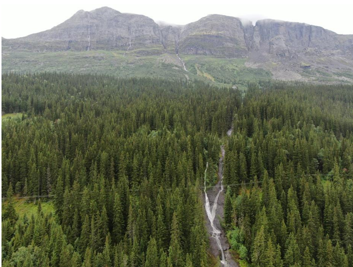
Figur 4 - Øvre del av skredområdet 28.7.2021. Foto: M Venås, SVV
