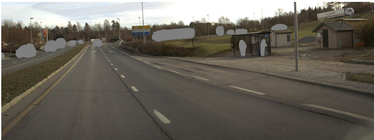
Bilde 1: Fra Vegbilder 2019 – spor og deformasjon.
