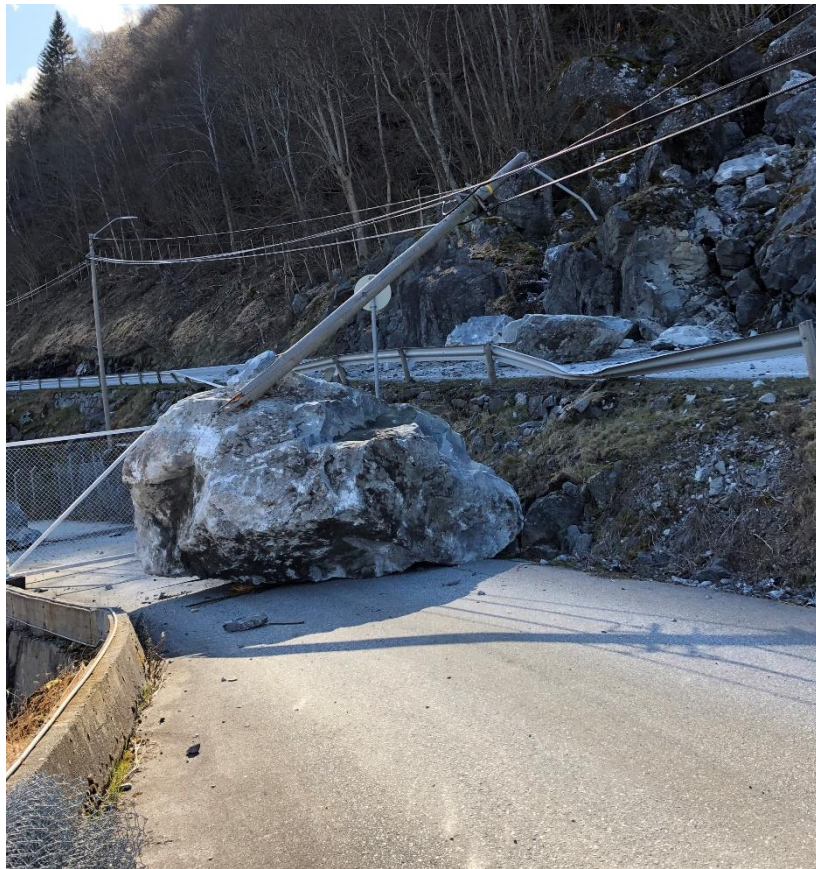
Figur 6: Delar av skredet gjekk ned på privat veg.
