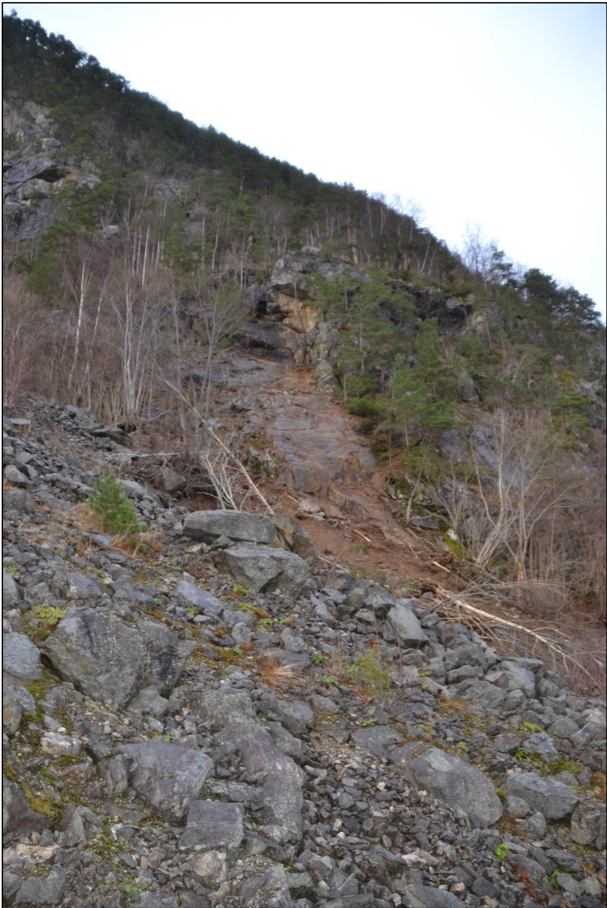
Figur 1. Torsdag 5. desember gikk et steinskred på Fv 5374 hp 1 km 5.060 Osa, Ulvik. Skredet løsnet fra en berghammer 50-70 meter over veg.
