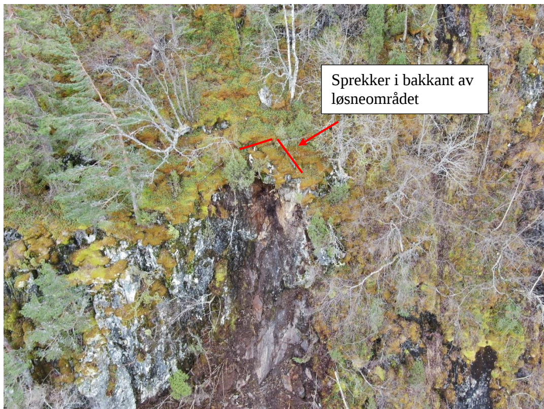
Figur 4 – Før det ble gjort befaring i terrenget, kunne det sees antydninger til sprekken i bakkant av løснеområdet. Dette ble senere bekreftet under arbeider og befaring i terrenget.
