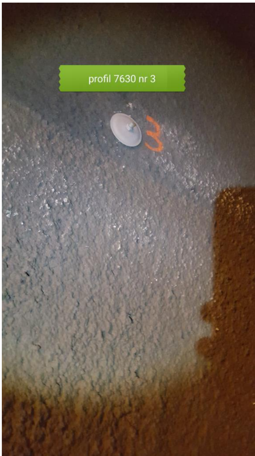
Bilde 6(over): Tetting av hull i hvelv etter gjennom boring for bolt 3 ved ca. pr. 7630 høyre side. Sett fra tunnelrommet.
