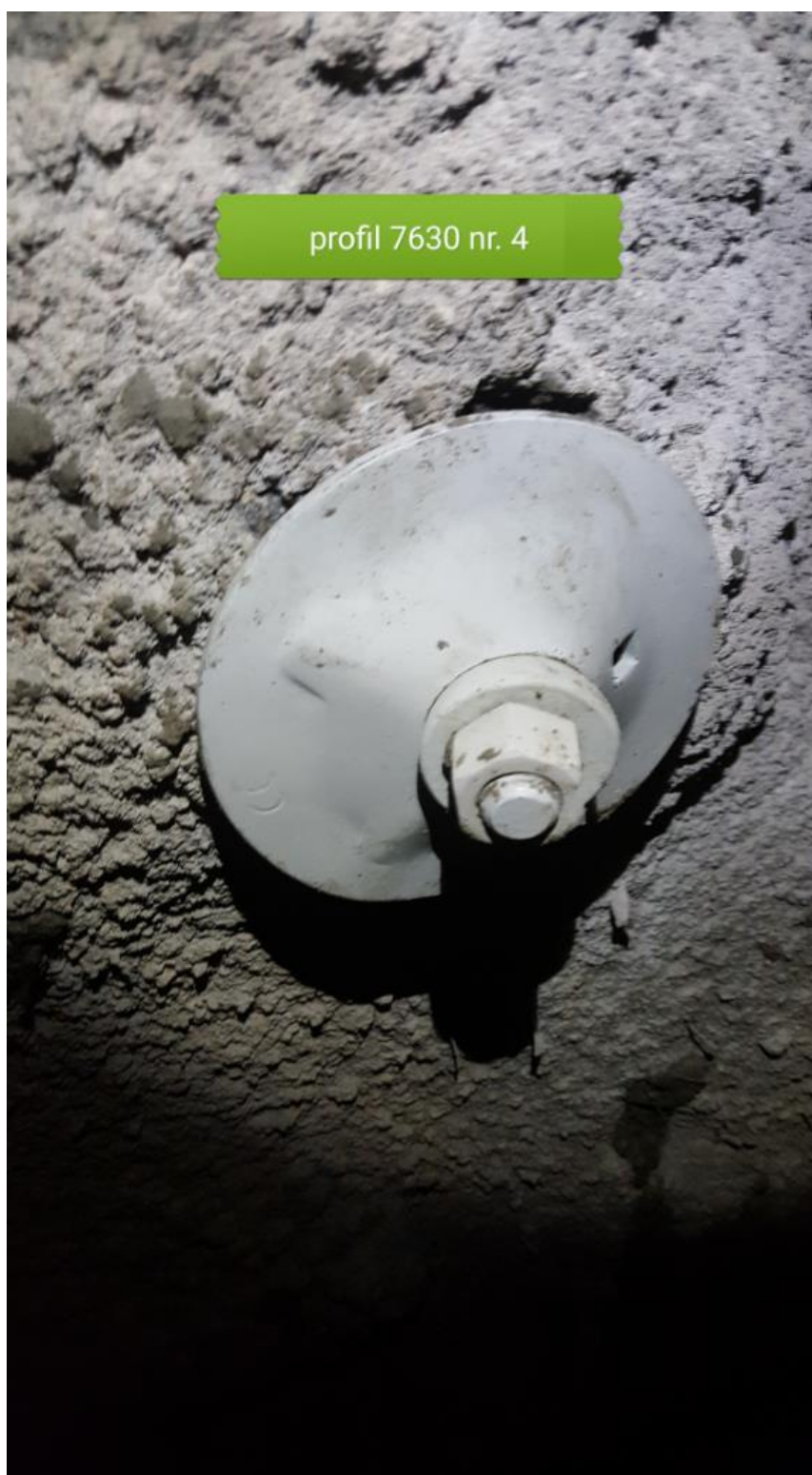
Bilde 7(over): Montert bergsikringsbolt i vegg bak hvelv ved profil ca. 7630 høyre side. Bolt nr. 4.
