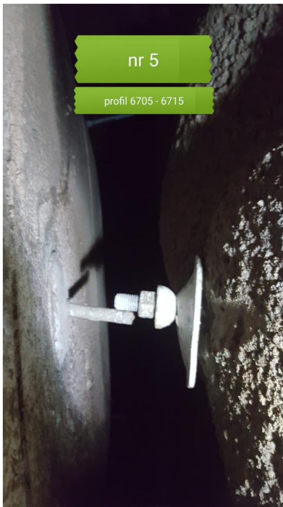
Bilde 9(over): Montert bergsikringsbolt i vegg bak hvelv mellom profil 6705 – 6715 høyre side. Bolt nr. 5.
