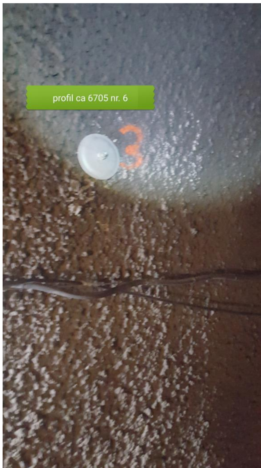
Bilde 12(over): Tetting av hull i hvelv etter gjennom boring for bolt 6 ved ca. pr. 6705 høyre side. Sett fra tunnelrommet.
