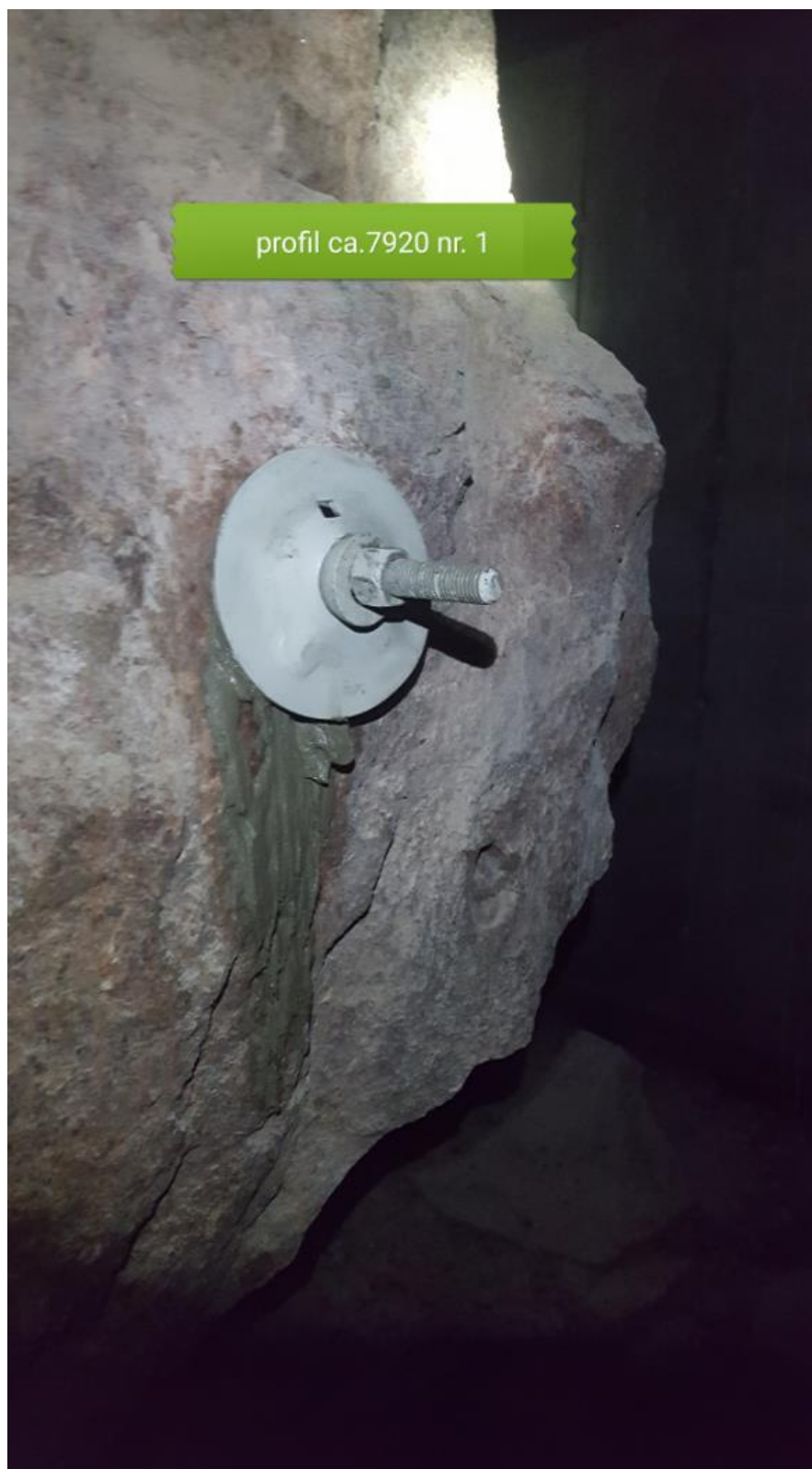
Bilde 1(over): Montert bergsikringsbolt i vegg bak hvelv ved profil ca. 7920 venstre side. Blokksikring i vegg ved teknisk rom T1. Bolt nr. 1
