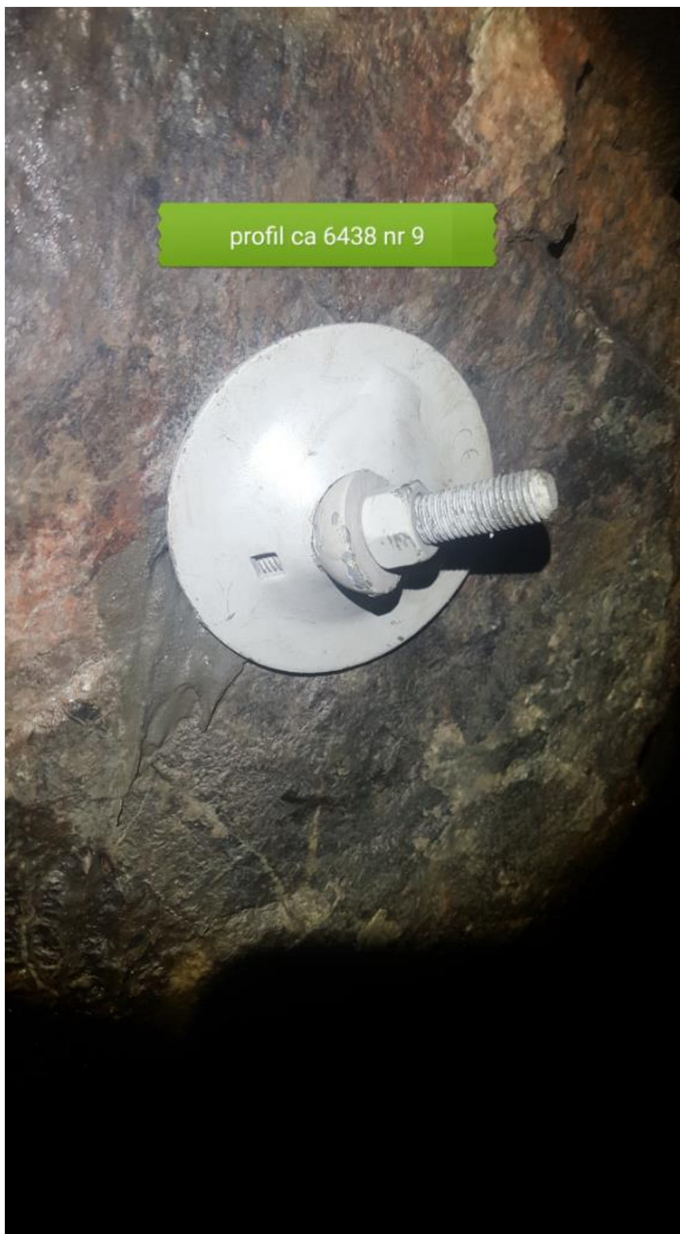
Bilde 17(over): Montert bergsikringsbolt i vegg bak hvelv ved profil ca. 6438 høyre side. Bolt nr. 9
