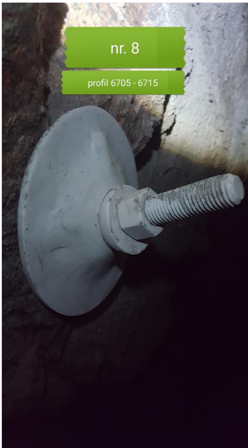
Bilde 15(over): Montert bergsikringsbolt i vegg bak hvelv mellom profil 6705 – 6715 høyre side. Bolt nr. 8.
