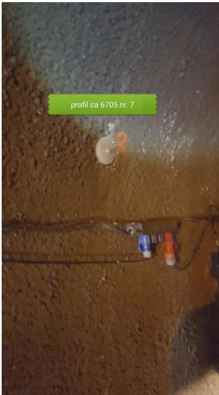
Bilde 14(over): Tetting av hull i hvelv etter gjennom boring for bolt 7 ved ca. pr. 6705 høyre side. Sett fra tunnelrommet.
