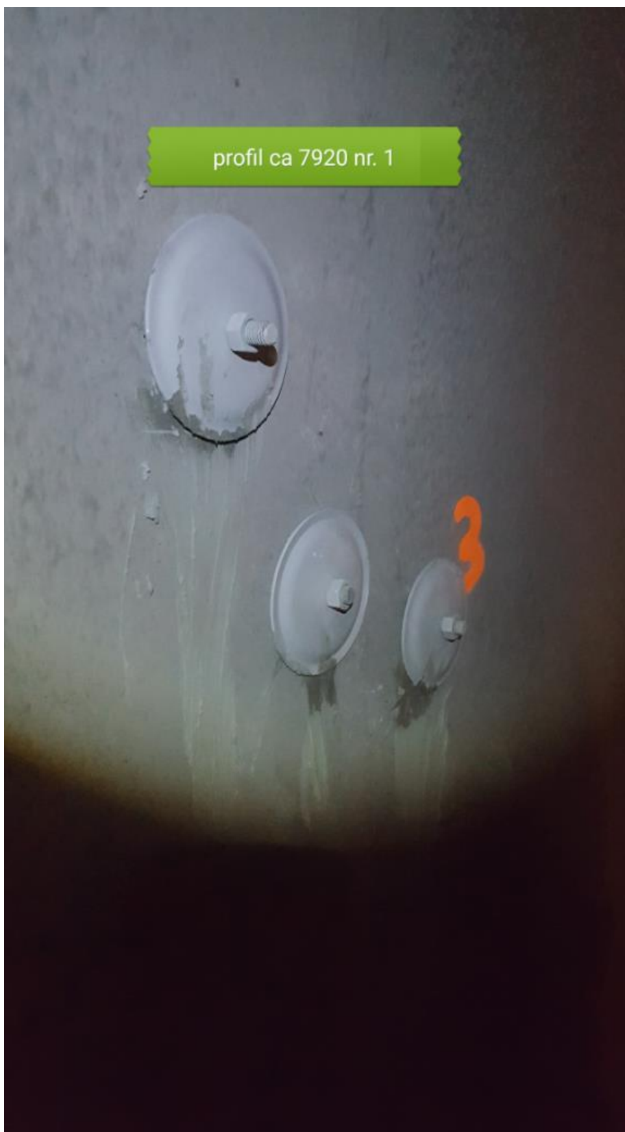
Bilde 2(over): Tetting av hull i hvelv etter gjennom boring for bolt 1 ved ca. pr. 7920 venstre side. Ved siden av teknisk rom T1. Sett fra nisje i tunnelrommet. Det var vanskelig å få boret gjennom veggelementet i nisja. Derfor ble det flere tettinger her.
