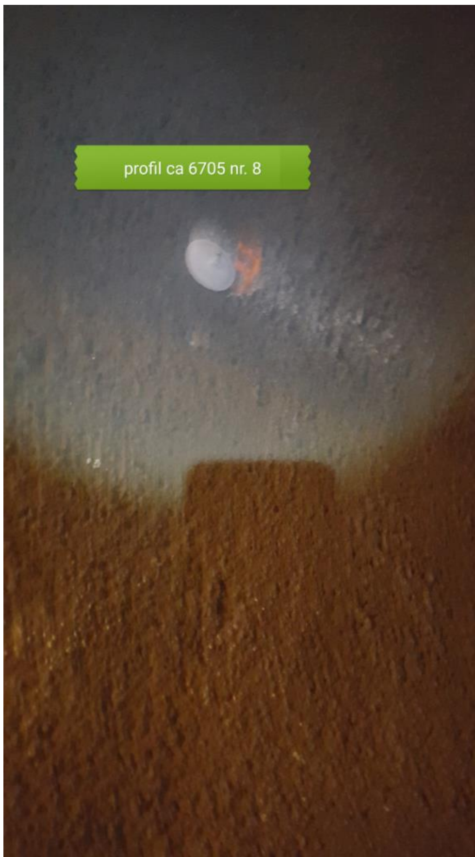
Bilde 16(over): Tetting av hull i hvelv etter gjennom boring for bolt 8 ved ca. pr. 6705 høyre side. Sett fra tunnelrommet.
