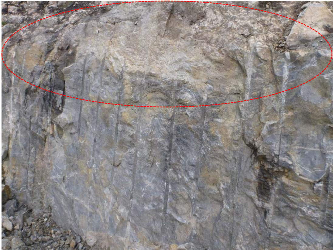
Foto 3: Videre vestover. Jevn skjæring. Noe renskebehov i topp.
