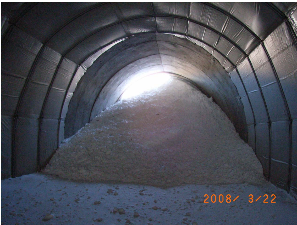
Foto 4: Rv.53, Jåteli, snøskred 21-3-2008, tunnel Jåteli I aust km 17,509
