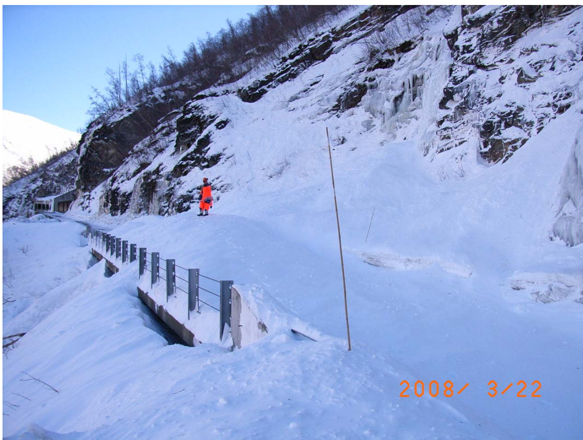
Foto 3: Rv.53, Jåteli, snøskred 21-3-2008, Øynajuvbekken km 17,800
