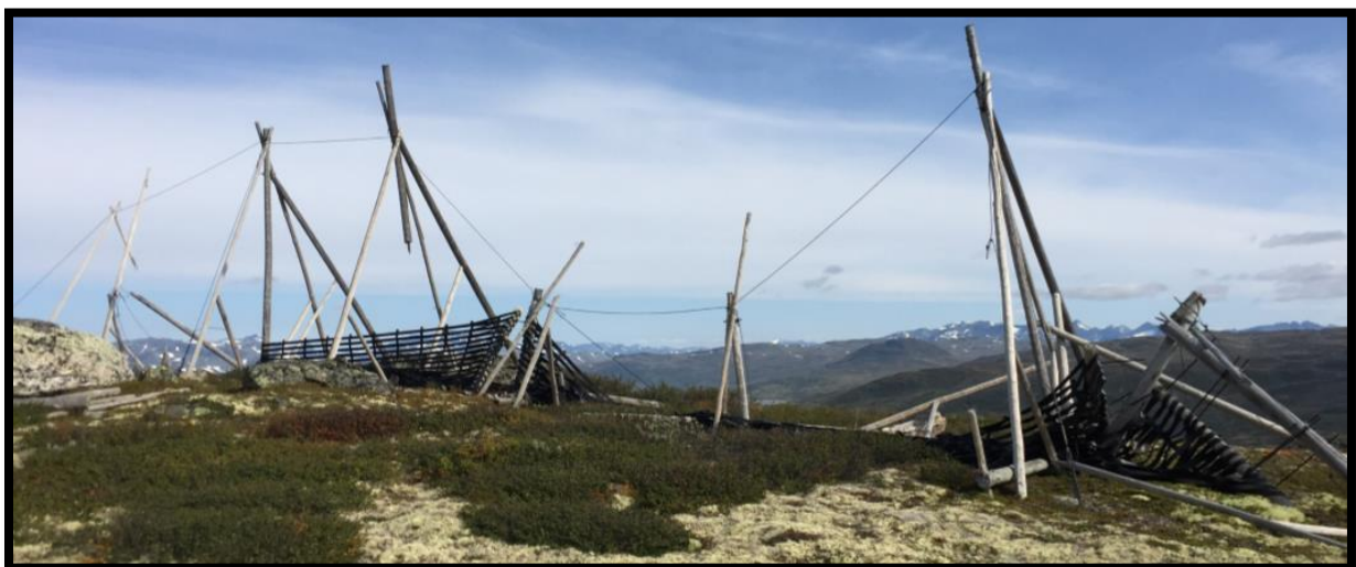
Figur 5 - Skjerm nr 3. Heile skjermen er øydelagt
