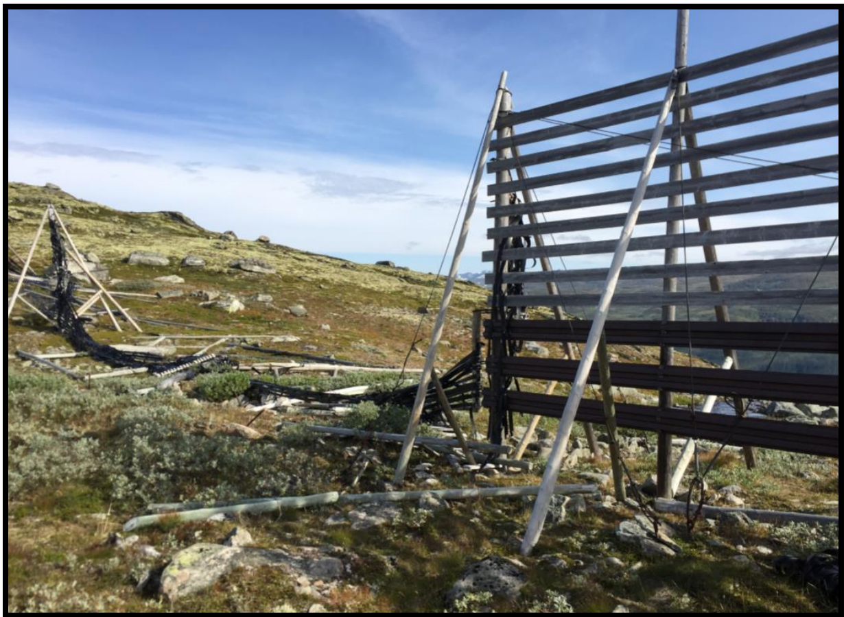
Figur 3 - Skjerm nr 1. Berre fyrste 6 lm er intakt. Resten er rasa ned
