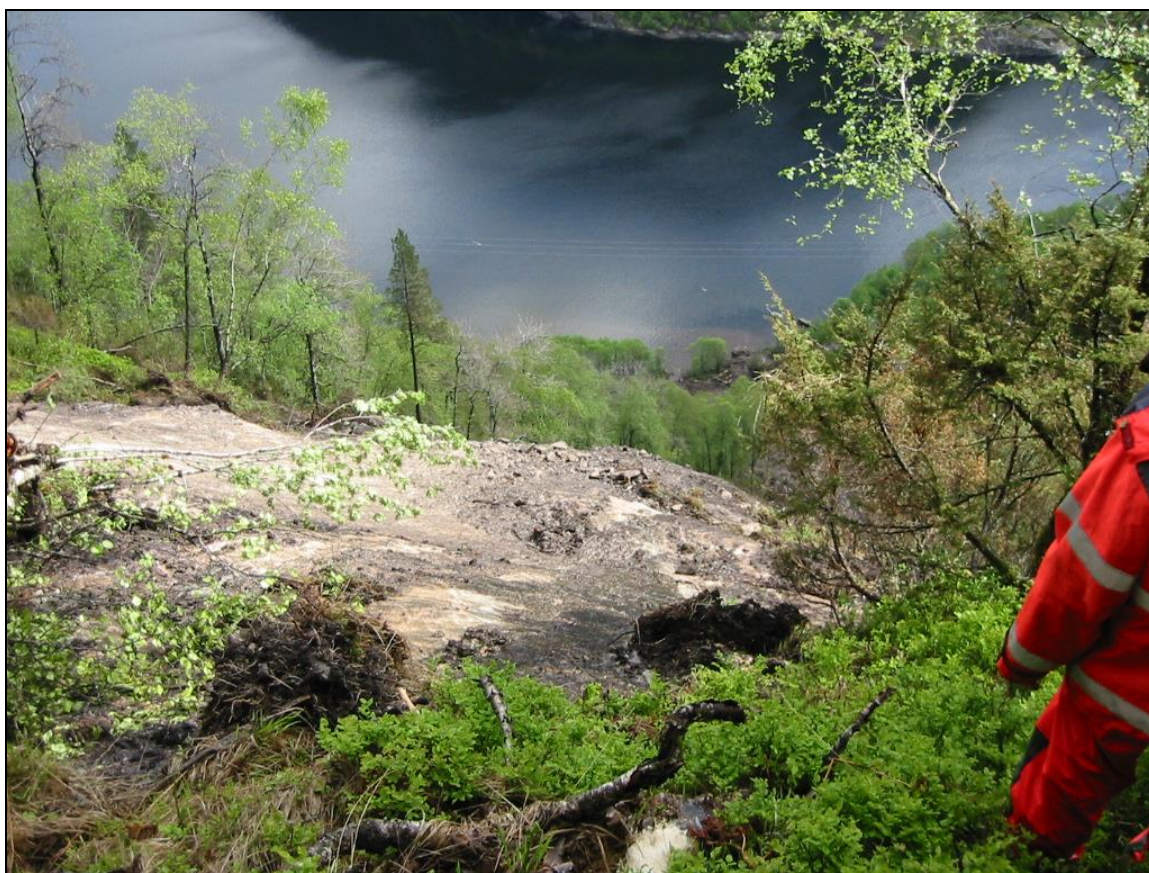
Figur 2. Skredløpet sett fra løsneområdet ca 320 m o.h. Bildet er tatt før spyling.
