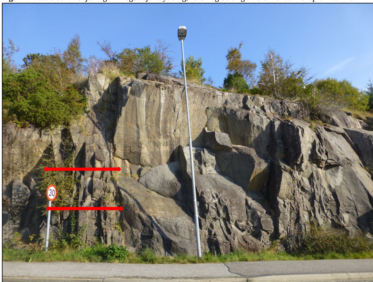
Figur 2. Eksempel på parti som bør sikres med fjellbånd. (Skjæringen fortsetter mot høyre ut av bildet).
