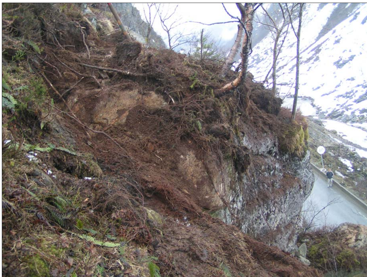
Figur 2. Blokken som ble sprengt ned sett mot sør.
