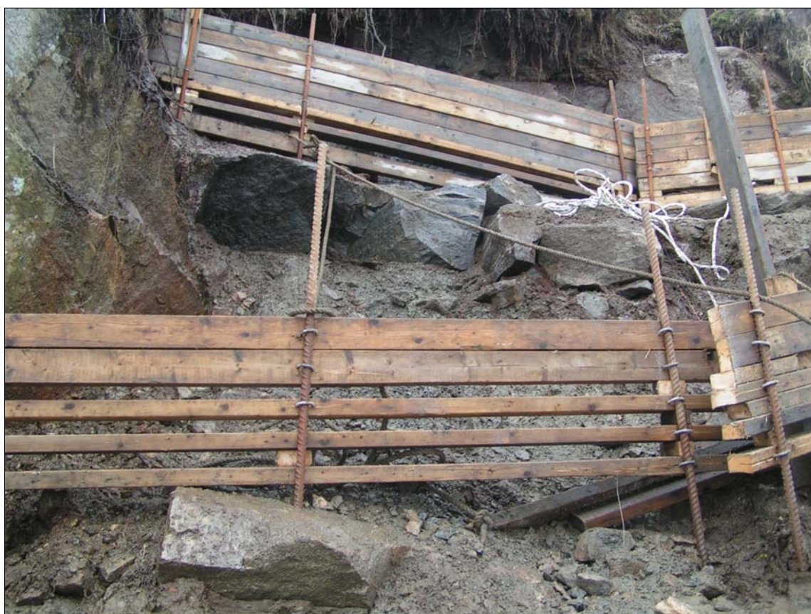
Figur 7. De to øverste "Sognemurene". Det er brukt kam 25mm jern som støtter. Noen av jernene er forankret i løse blokker.
