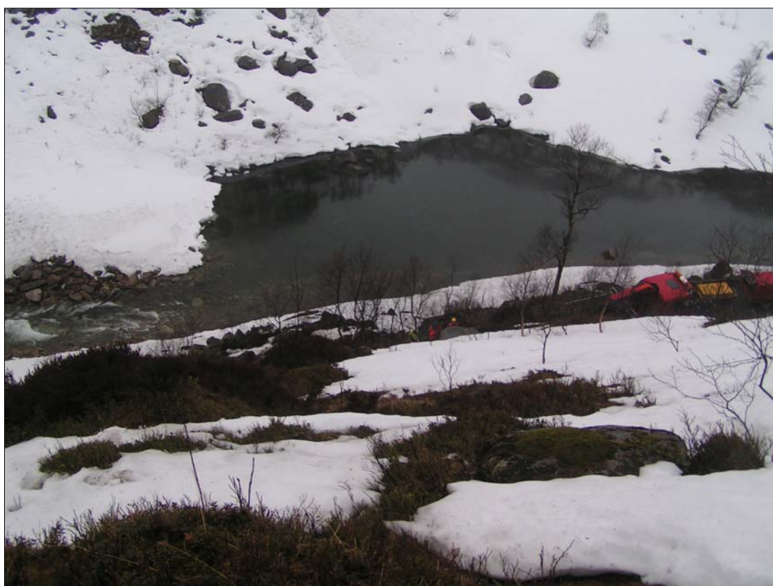
Figur 10. Skråning som heller ca 35 grader ned mot nedfallsområdet. Terrenget består av morenemasser i overflaten. Inspeksjoner må følge opp utviklingen i dette området.
