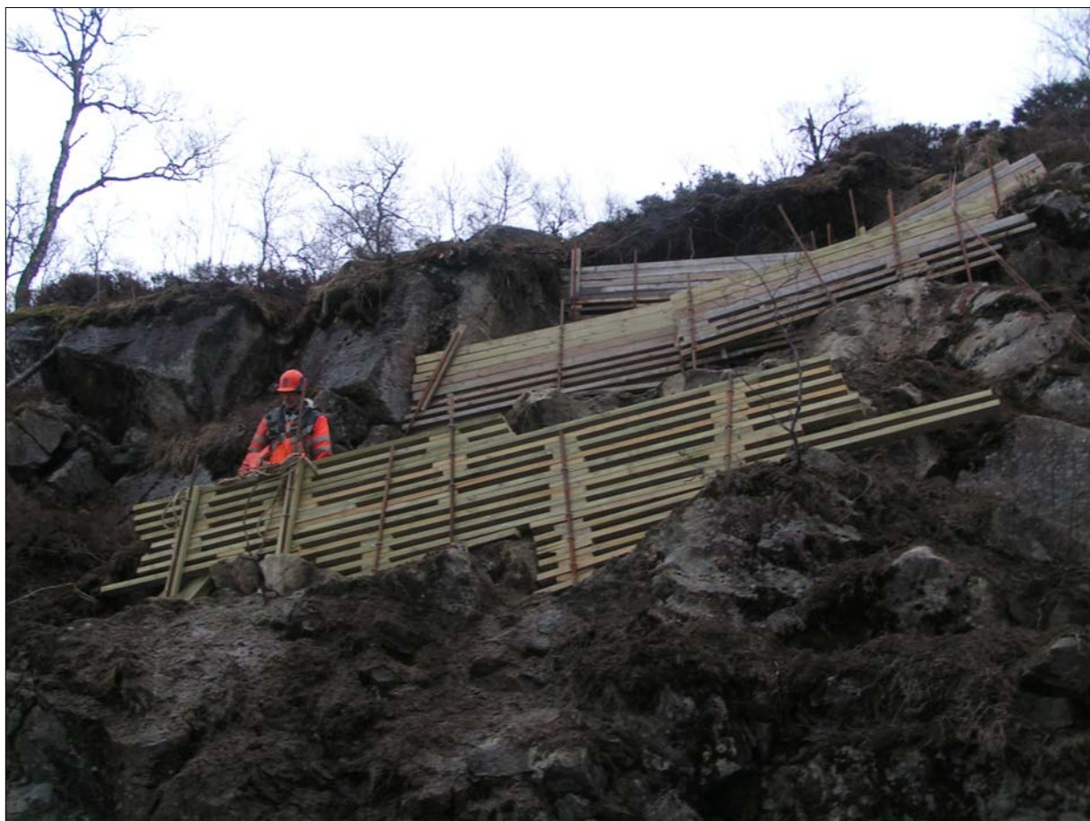
Figur 8. Skredløpet etter sikring.
