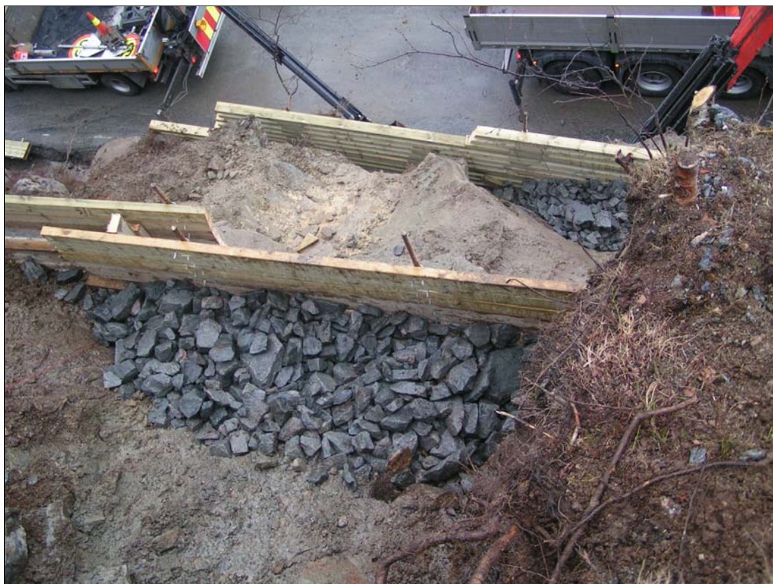
Figur 9. Ferdige murer med bakfyll.
