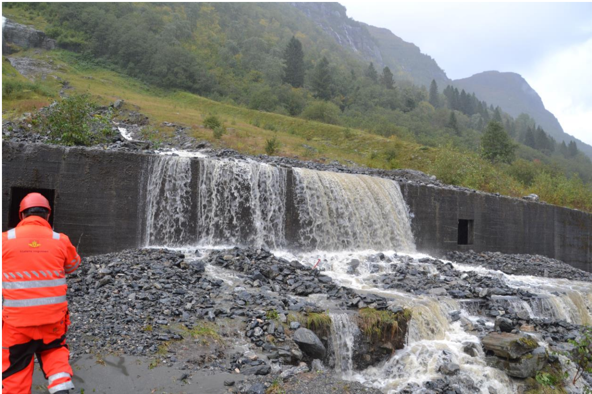
Figur 2 – Skredmassar i veg. Merk stor vassføring og tett drenering
