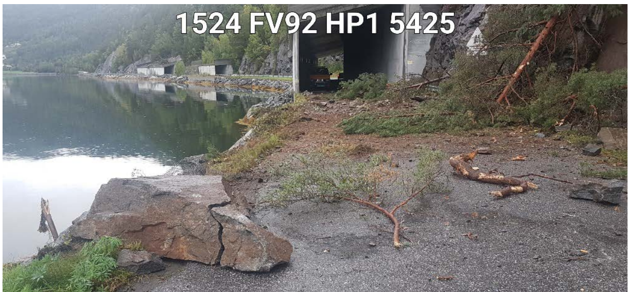
Figur 7. Fra skredstedet før vegen ble ryddet.
