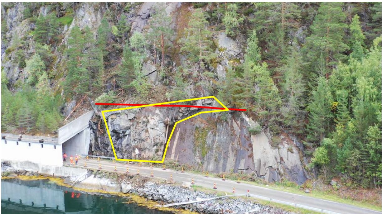
Figur 8. Fanggjerde i rødt (40 m langt) og bergsikring i gul.
