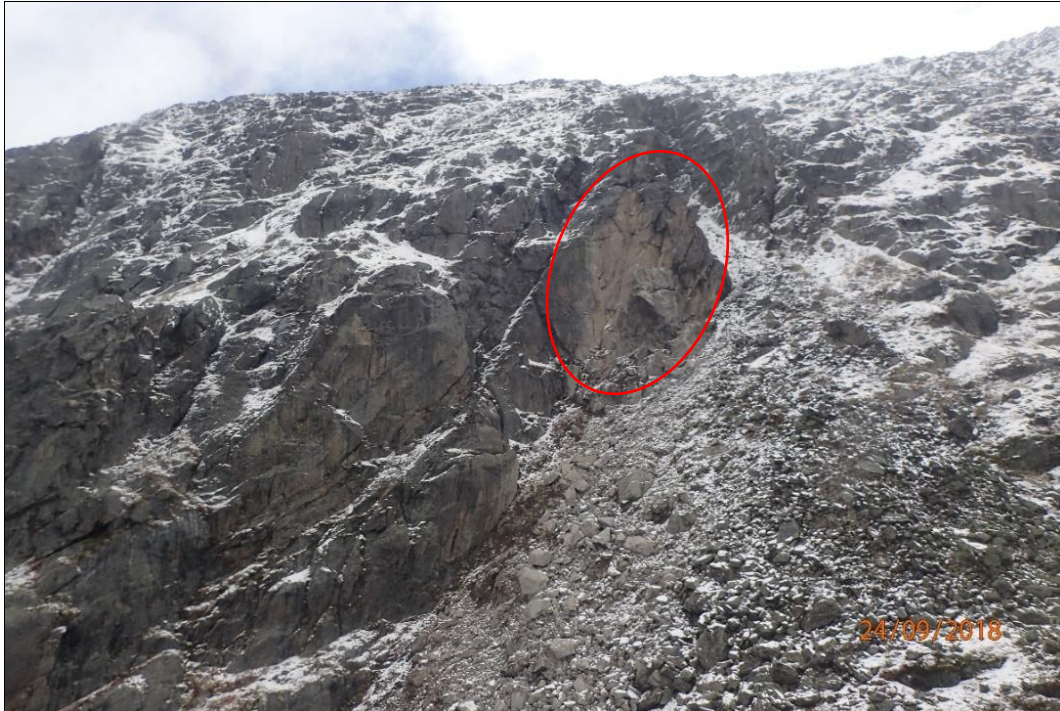
Figur 6: Foto av løsneområdet, se lysebrunt område inne i rød sirkel. En steiltstående større bergskive har rast ut fra et oppsprukket bergmasseparti. Partiet tolkes å ha hatt dårlig fot som gradvis har sviktet, og endelig utløst av siste tidens nedbør i kombinasjon med fryse-tine prosesser. Det ble observert flere blokkpartier i og rundt løsneområdet som vurderes å ha dårlig stabilitet. Det er sannsynlig med nye utfall fra området i kommende høst-vinterforløp, men disse tolkes å ville være av betydelig mindre volum enn nylig utrast parti. Det er fremdeles stor skredfare i og rundt løsneområdet. De urdekte hyllene nedover fjellsiden har god friksjon/fangevne med tanke på nye steinsprang. Grunnet at nye utfall tolkes med mindre volum, samt at det er mye ur (nå enda mer etter siste hendelse) vurderes det lite sannsynlig at steinsprang vil kunne nå vegen, som ligger plassert på motsatt side av elva i nedenforliggende dalbunn.
