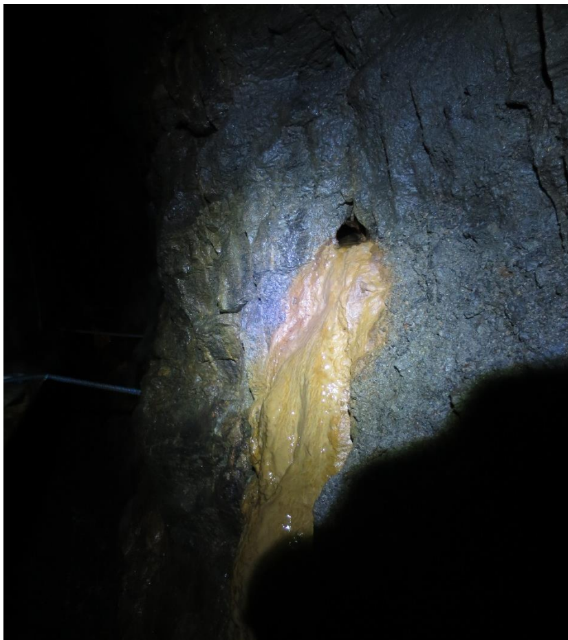
Bilde 3 – Stedvis var det mye utfelling fra tunnelveggen. Dette er ikke kartlagt nærmere.
