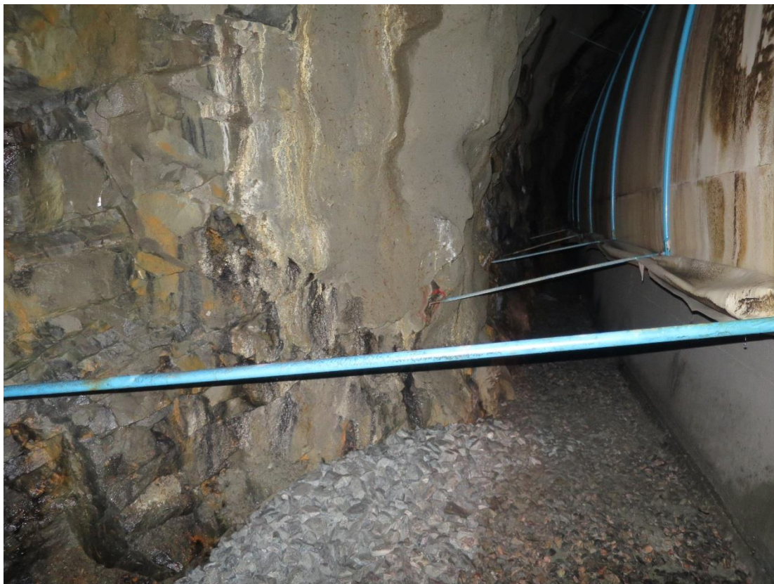
Bilde 2 – Duk festet til fjellveggen for å føre vann ut til sidene. Pga. av duken er deler av tunnelen ikke inspisert. Ny føringskant til høyre i bildet.
