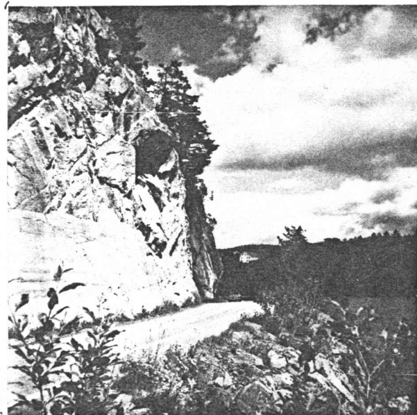
6a. 25 m høy skjæring, delvis støttet opp av mur.
