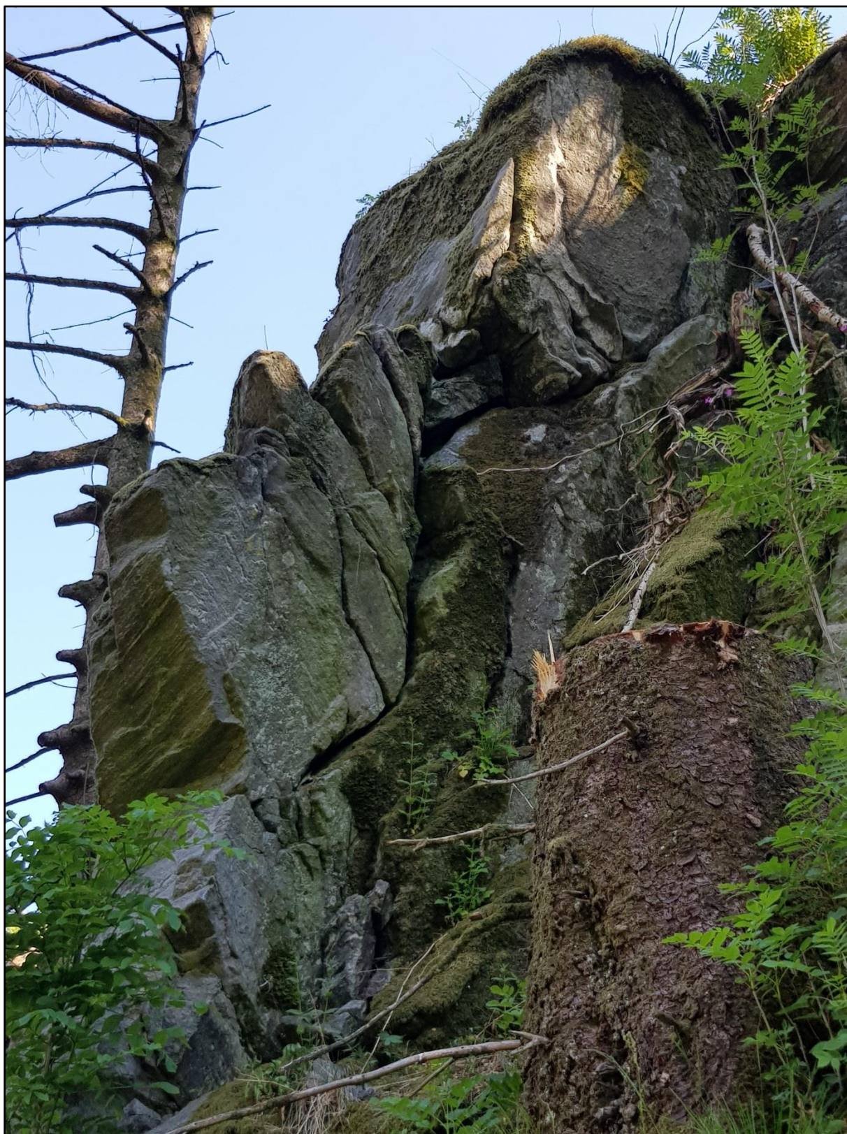
Figur 1: Sprekkeavlasta blokker som kviler på ein liten fot. Det anbefales å ta ned begge blokkene.
