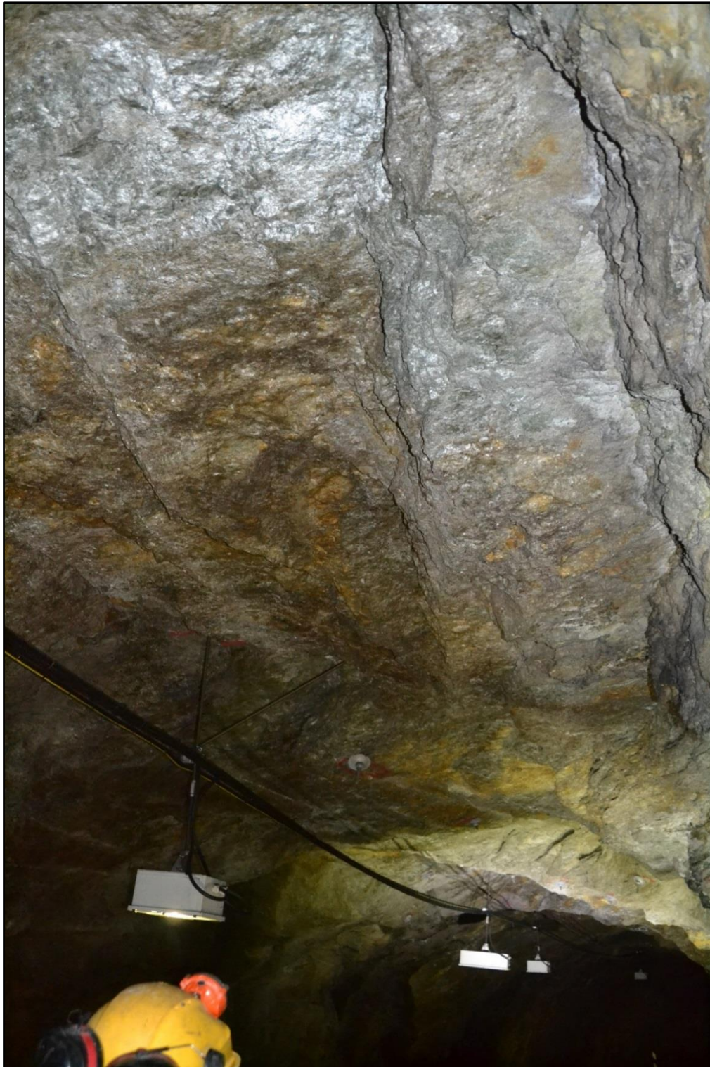
Figur 1: Mjuk glimmerskifer som er tett oppsprukken. Ein kan reiske og reinske på dette strekket utan at det vert så mykje betre.
