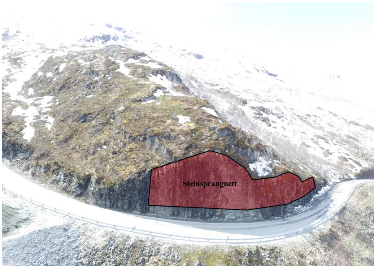
Figur 4: Plassering av steinsprangnett i høy skjering. Markert område på skjering er om lag 200 m 2 .
