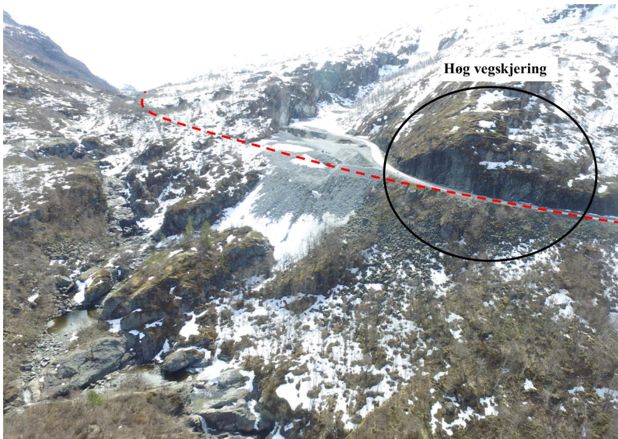
Figur 2: Høg vegskjering som må reinskast og sikrast. Stipla raud strek viser planlagt veg.
