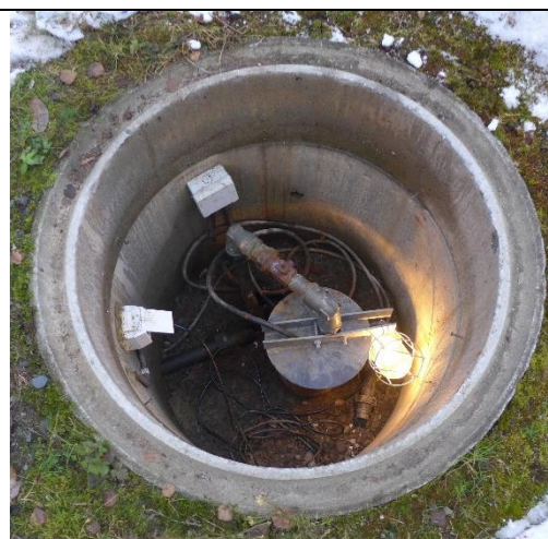
Figur 3 Brønn ved kyllingfjøs (nr. 4) på eiendommen 136/1. Brønnen har et plastlokk som hindrer tilgang for vannstandsmåling.
