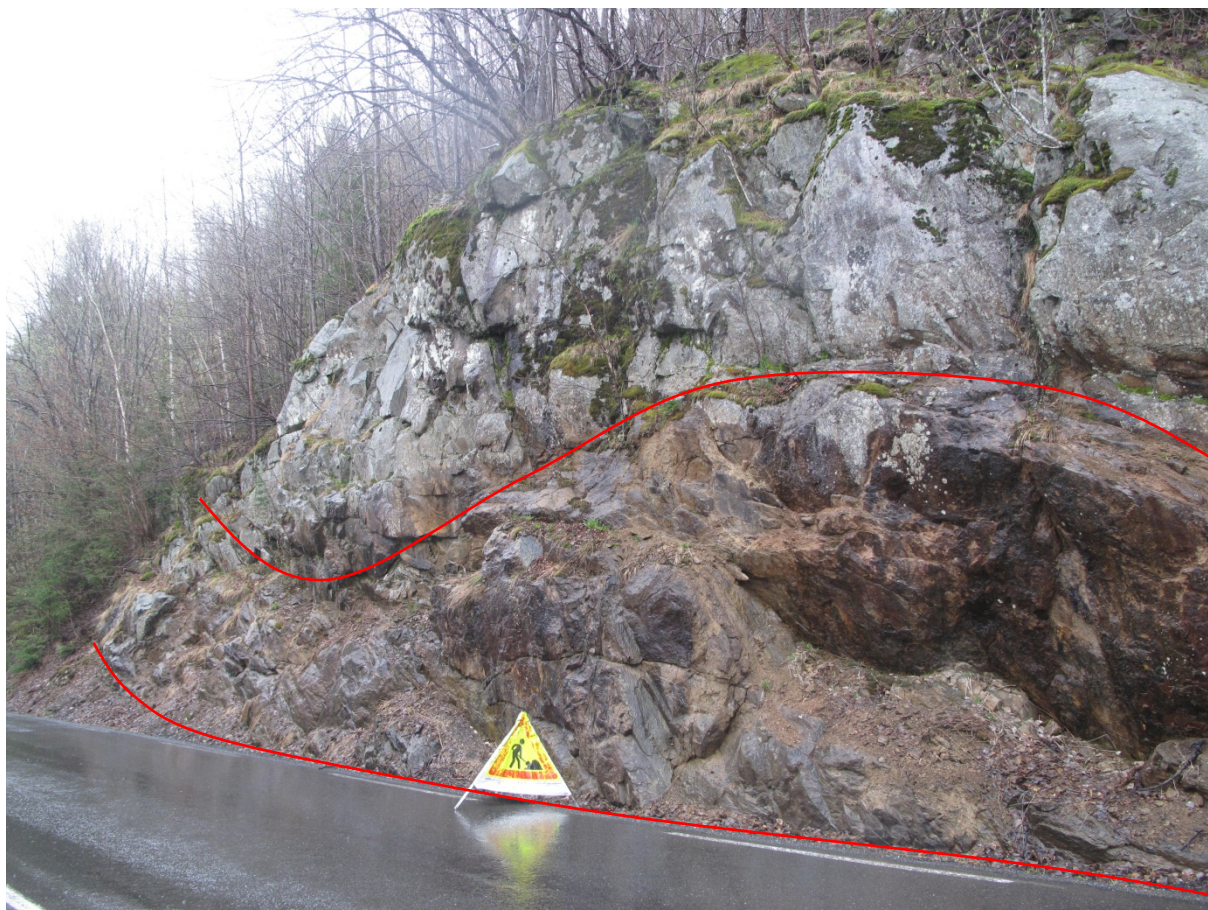
Figur 2: Eksempel på forvitret svakhetssone som stryker nær parallelt med vegen (mellom røde linjer).
