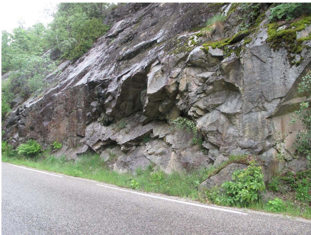
Figur 2: Kubisk blokkdannelse på steilt underliggende glideplan.
