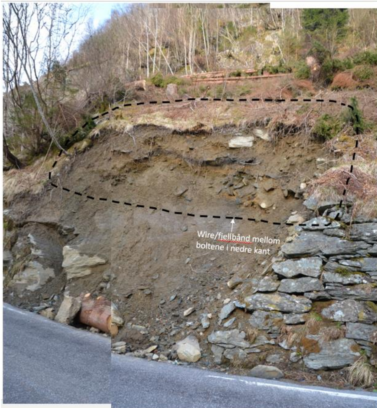
Figur 2: Bruddkanten sikres med Macmatnett eller tilsvarende (markert med sort stiptet linje). Nettet festes i overkant om lag 2 meter fra bruddkant. Kan bli behov for selvborende stag for å feste i toppen. Figuren er sammensatt av to bilder for å se hele bruddkanten, derav ulikheter i nederste del av bilde.
