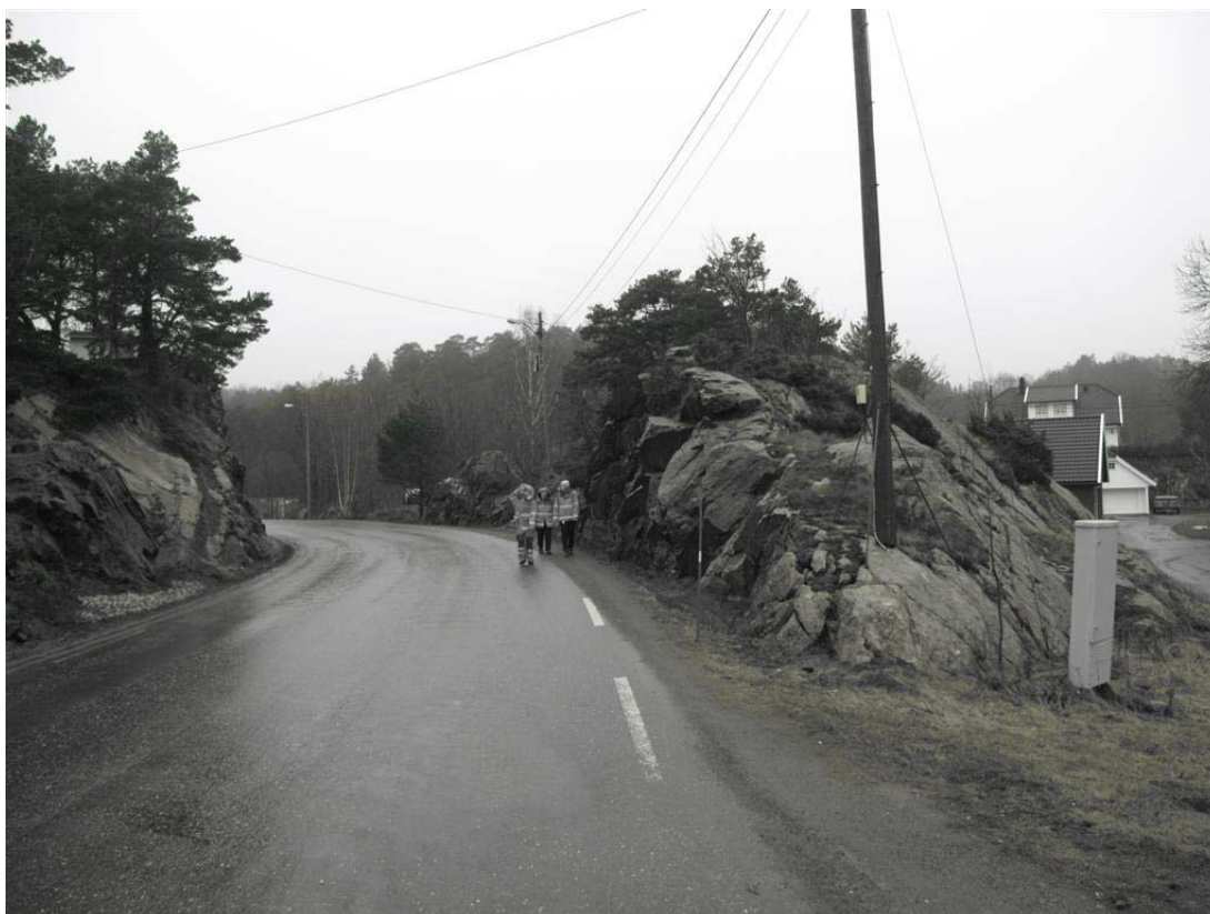
Figur 4: Ny skjæring kommer på høyre side av vegen.
