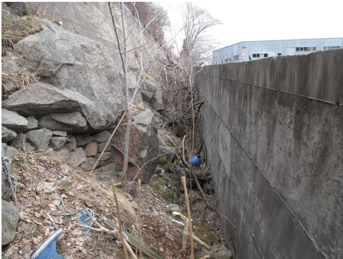
Figur 3: Bak støttemur langs kaianlegg.
