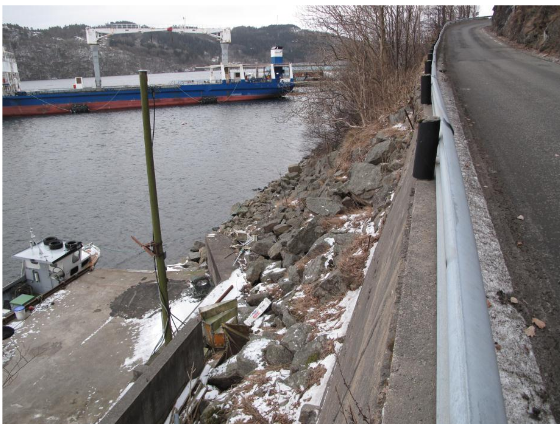
Figur 5: Grov steinfylling over havnivå.
