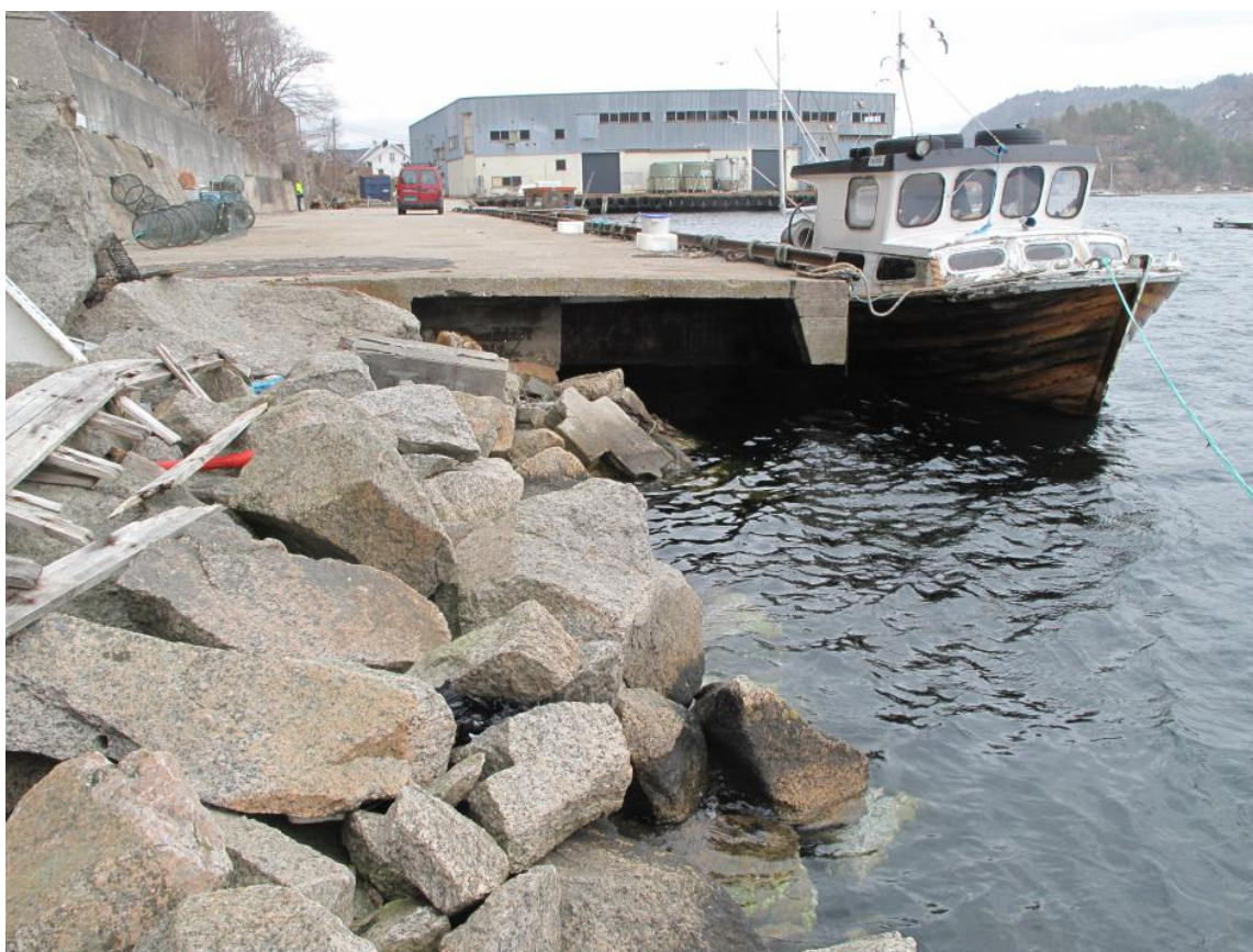
Figur 2: Kaianlegg med betongdekke på utragende ståldragere.
