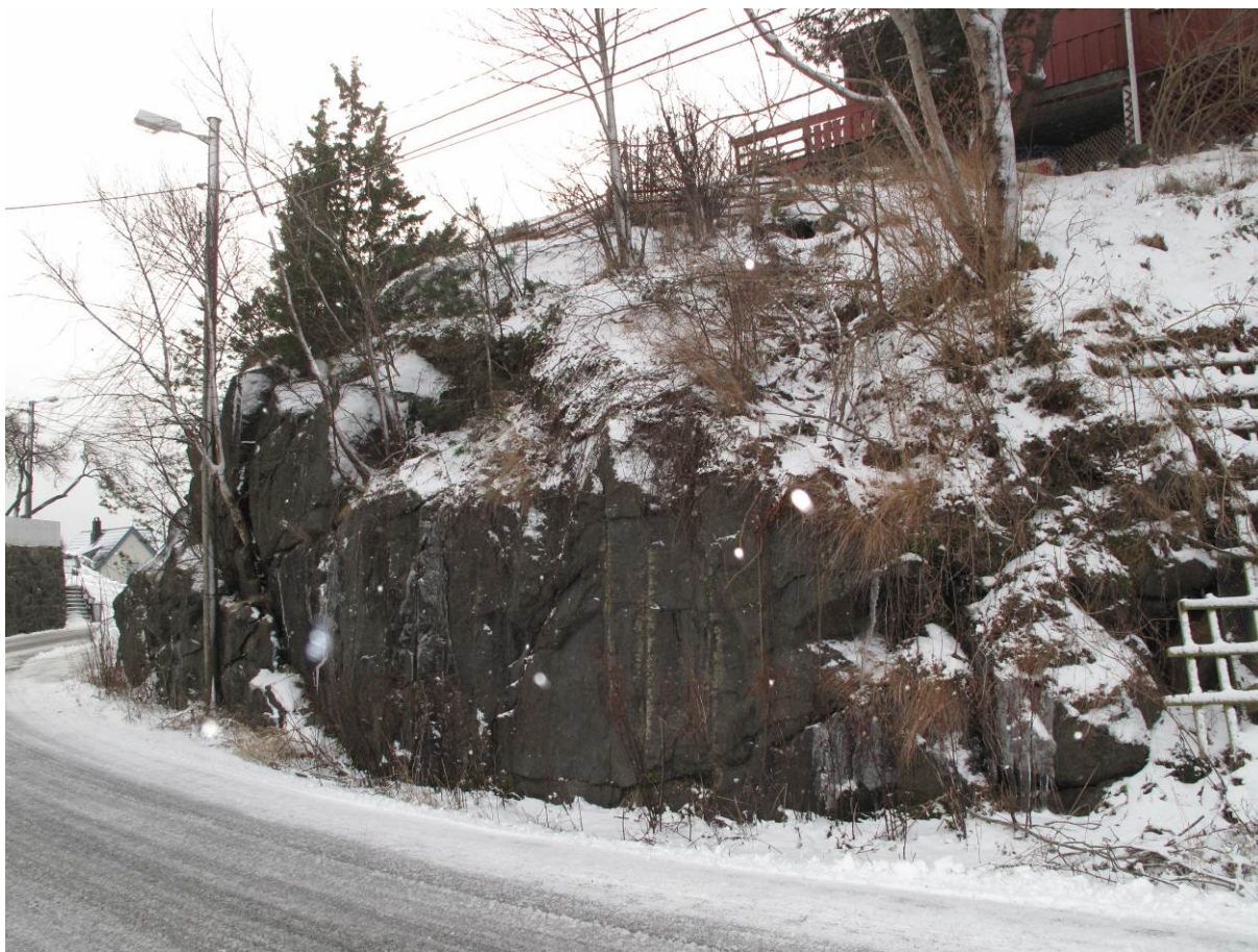
Figur 4: Dagens skjæring ved pr. ca. 2520.
