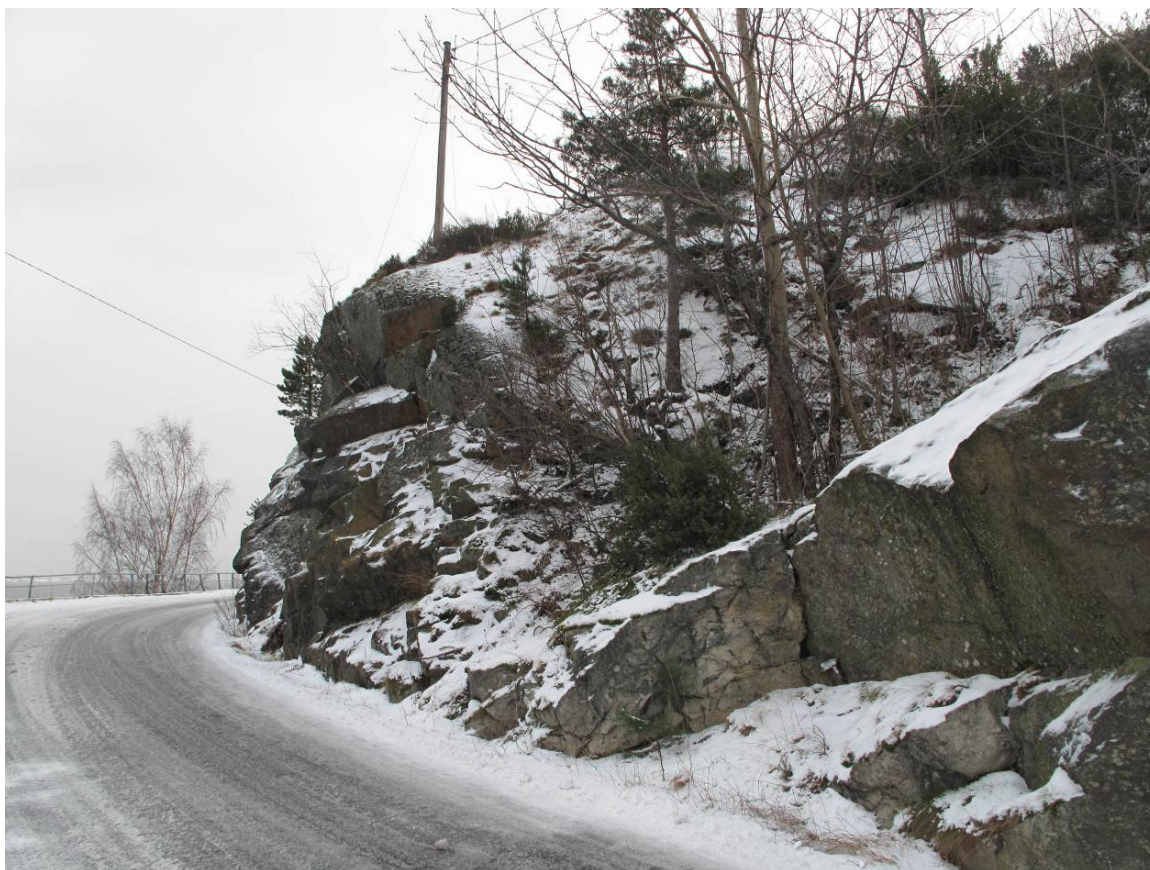
Figur 1: Kranveien, høyeste del av skjæring.
