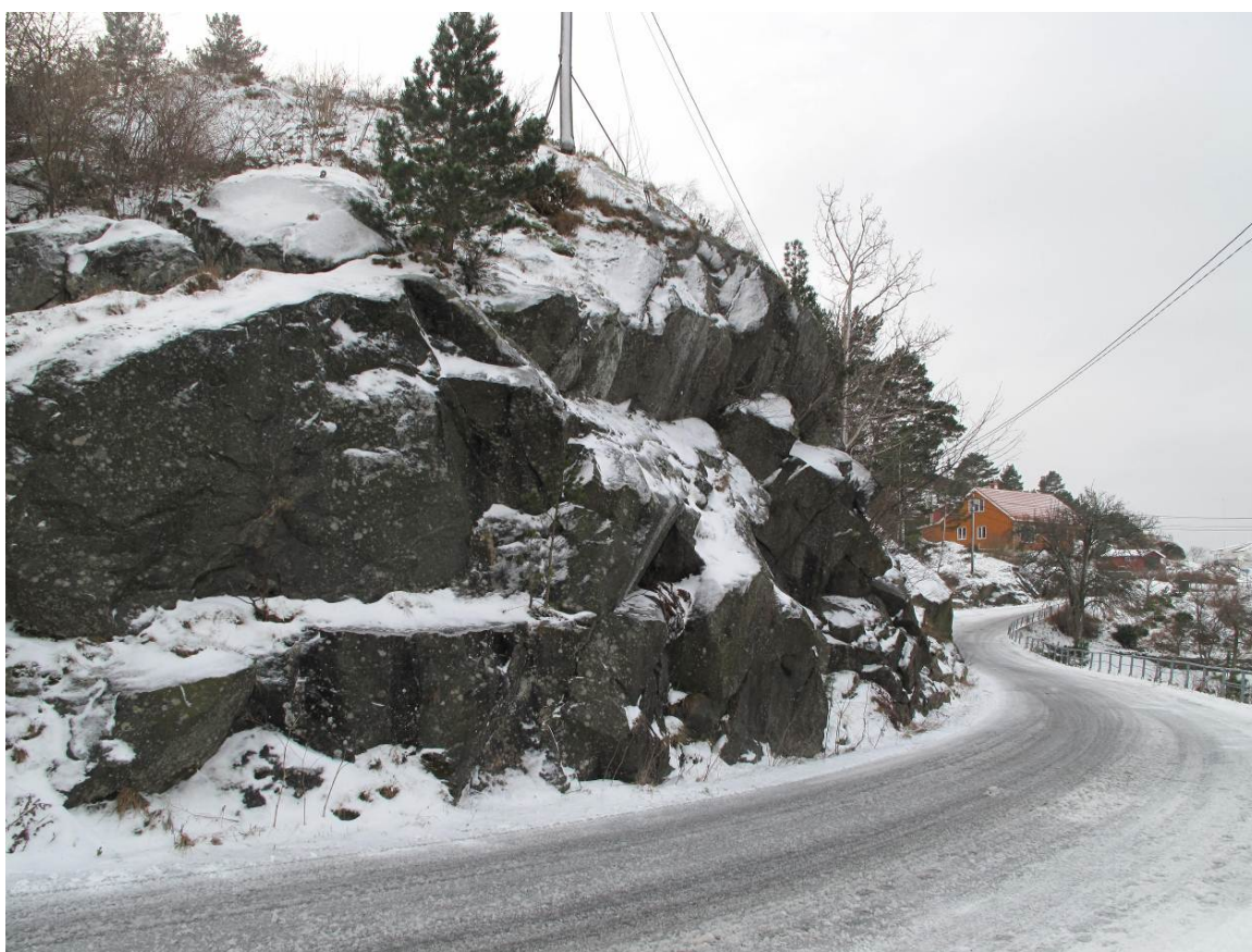
Figur 2: Kranveien, bilde tatt mot vest. Stolpen i øvre billedkant er ca. ved pr. 2260.
