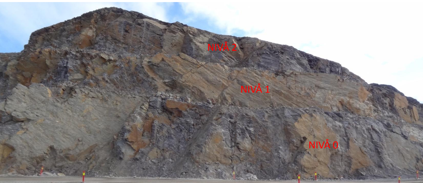
FV 889 - Skjarvelandet Foto 1: Det er utsprengt bergskjæring i 3 paller med ca. 30 meter høyde totalt, der vær pall er ca. 10 meter høy og ca. 5 - 10 meter bred. Geo- og laboratorieseksjonen Statens vegvesen
