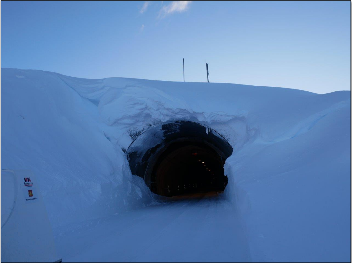
Figur 9: Storehaugtunnelen nord 26.november.
