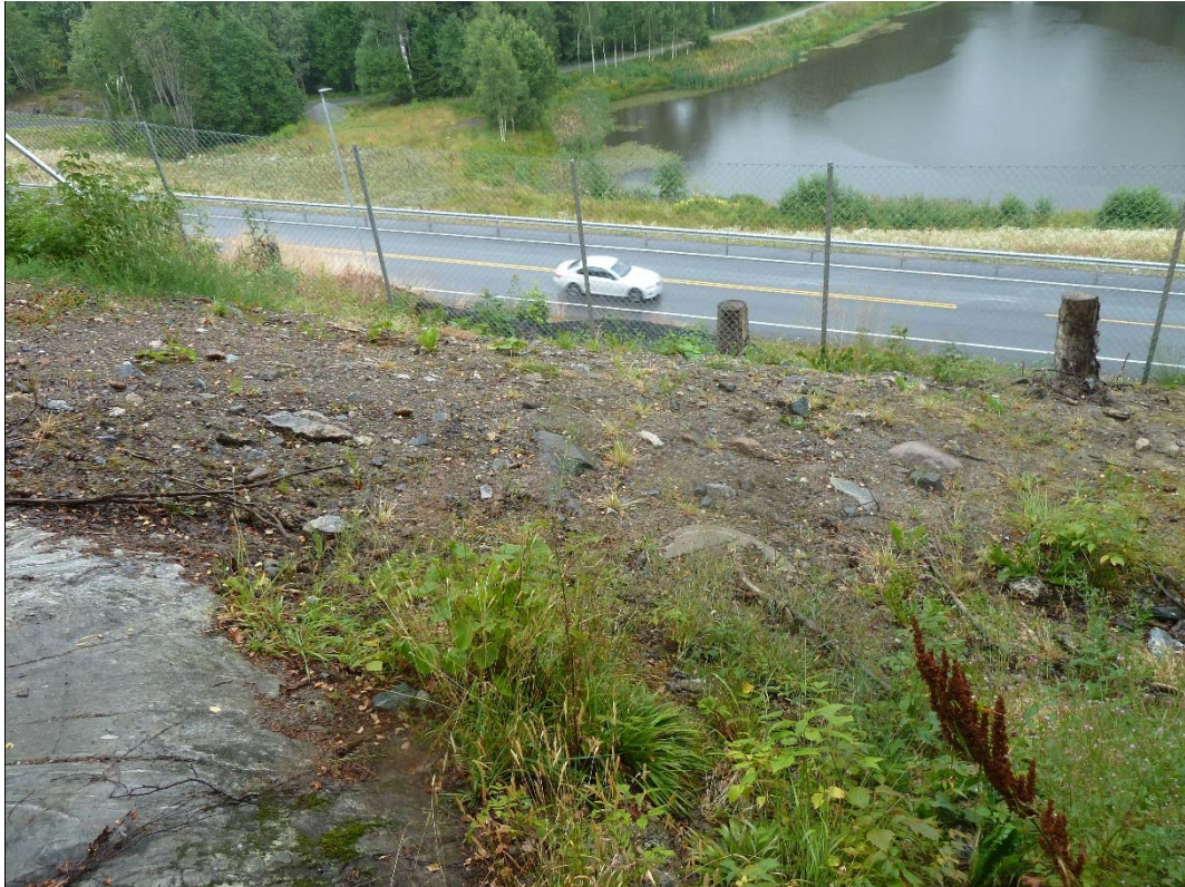
Fig 5: Ca km 3,990. Tolkast gradvis grunnare på fjell bakover frå losneområdet mot bart fjell i bakkant. Det vurderast tilrådeleg å ta vekk lausmassane frå bruddkant og bakover mot bart fjell. Det er tilkomst frå anleggsveg på oppsida for gravemaskin. Utføring av arbeid må vurderast anleggsteknisk med tanke på HMS for å sikre at ein kontinuerleg står trygt. Det er tilrådeleg med lang arm på graver, for å unngå å stå utsett til. I bakkant får ein overgang mot bart fjell, sidevegs vil det måtte tilretteleggast stabil skråning, eventuelt kombinert med nettsikring for å hindre erosjon.
