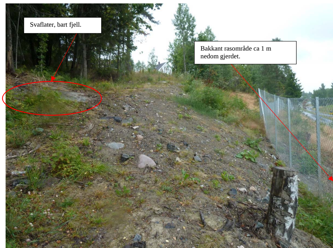
Fig 4: Ca km 3,990. Området vidare bakover relativt slakt, er og ein tillaga anleggsveg i området. Det tolkast slik at massane gradvis vært tynnare bakover mot observerte fjellflater i bakkant.
