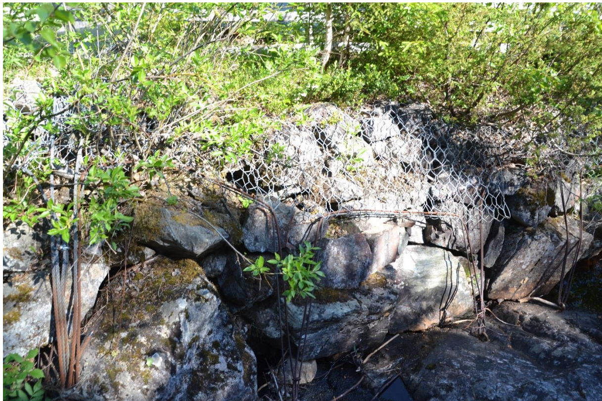
Figur 2 - Forankring og sikring med vaier og nett i grøfta i bakkant
