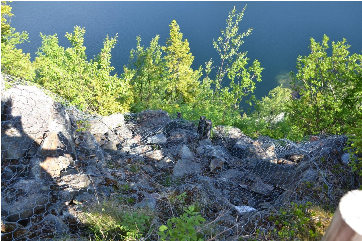
Figur 3 - Sikringsnett over røysa etter tørrmuren
