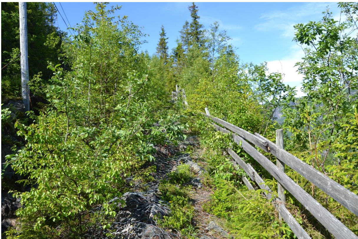
Figur 4 - Kongevegen med gjerde og sikringsnett over. Mykje vegetasjon gjer vegen smalare. Merk grøfta til høgre der det tidvis er vassføring
