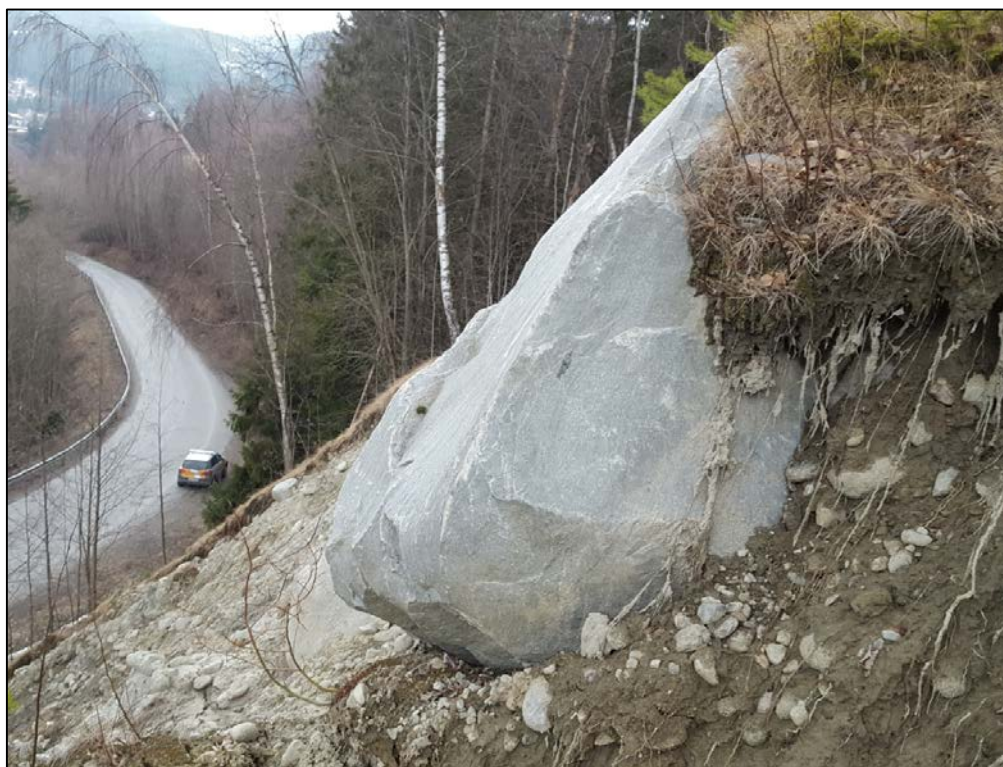
Figur 3. Blokka i Figur 2 sett frå sida. Blokka ligg på ei «relativt flat hylle» per dags dato, og ligg relativt stabilt. Men lausmassane under og kring blokka kan på sikt bli vaska ut og gjere blokka meir ustabil. I tillegg kan tine- og fryseprosessar «løfte» opp blokka, og gjere denne meir ustabil. Foto: Marius Y. Meland, SVV.
