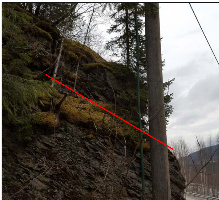
Figur 3. Blokka i Figur 2 sett frå sida. Raud strek indikerer potensielt utglidingsplan. Dersom alternativet med forankring av boltar blir valt, bør dei plasserast med lengd på minst 1,5 meter innanfor utglidingsplanet. Originalfoto: Marius Y. Meland, SVV.
