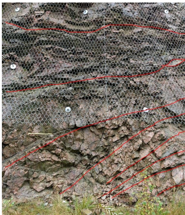
Figur 4 – Nærbilde (bak skilt på figur 3) av interne skjærbånd som er avbøyd opp mot høyre og hoved båndet på figur 3. Linjal på bildet er 50 cm.
