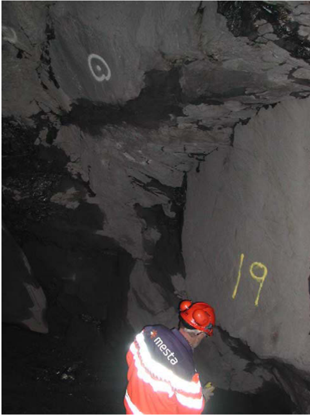
Figur 9 Lokalitet 19 ved km 6,454. Område som fra før er merket for bolting.
