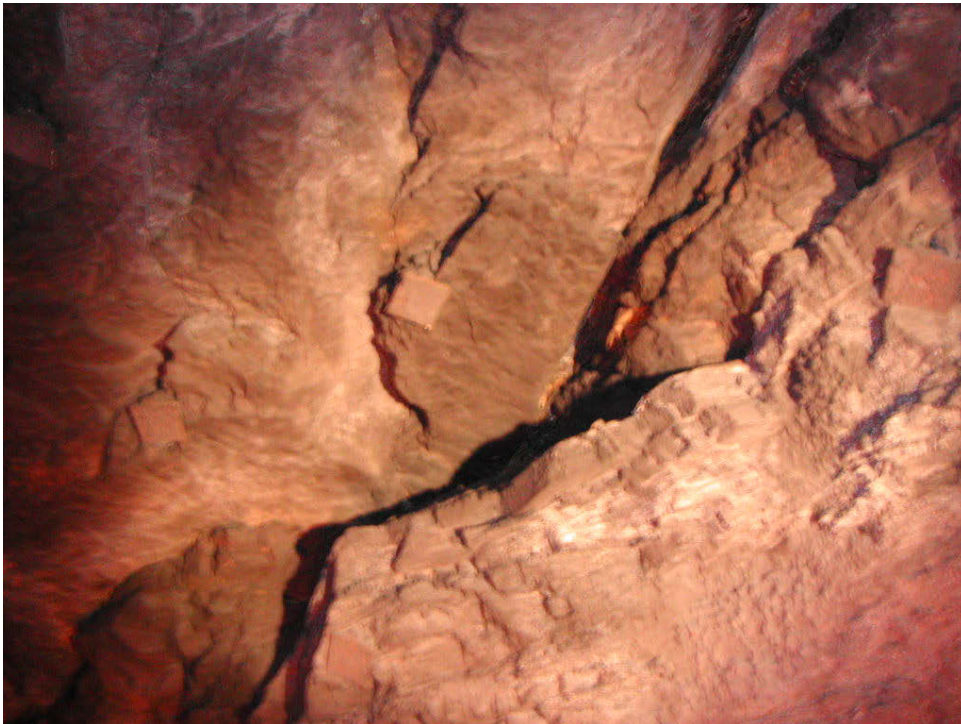
Figur 4 Lokalitet 7 ved km 4,927. Brede åpne sprekker, særlig på nordsiden.
