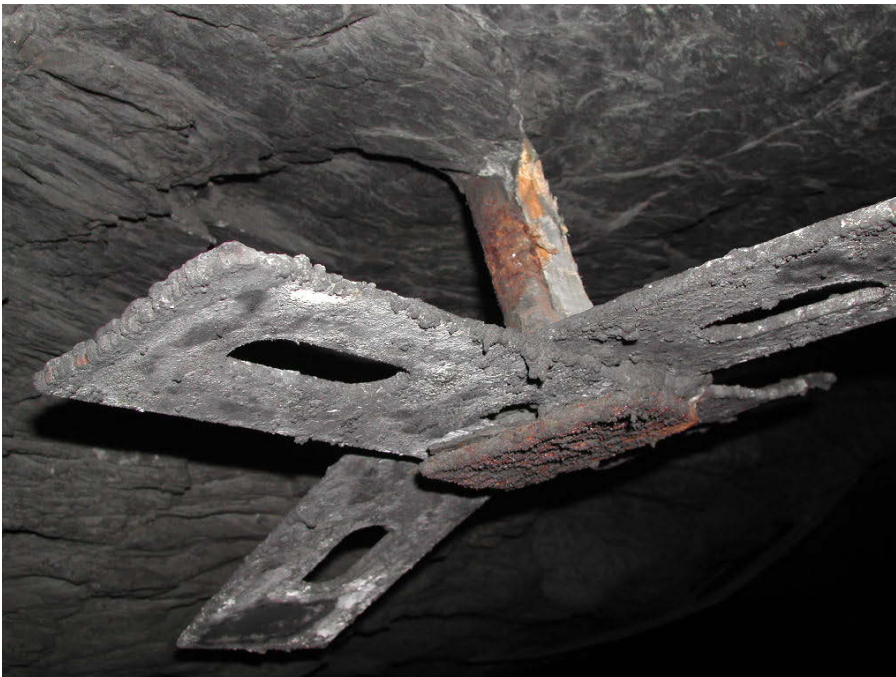
Figur 10 Lokalitet 23 ved km 7,891. Fjellbånd som ser ok ut, men usikkert hvor gode boltene er.
