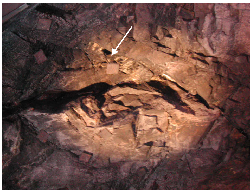
Figur 2 Lokalitet 2 ved km 4,563. Blokk er sikret med bolter, men den er oppsprukket. Bolt med fri ende (pil) - pga utfall?
