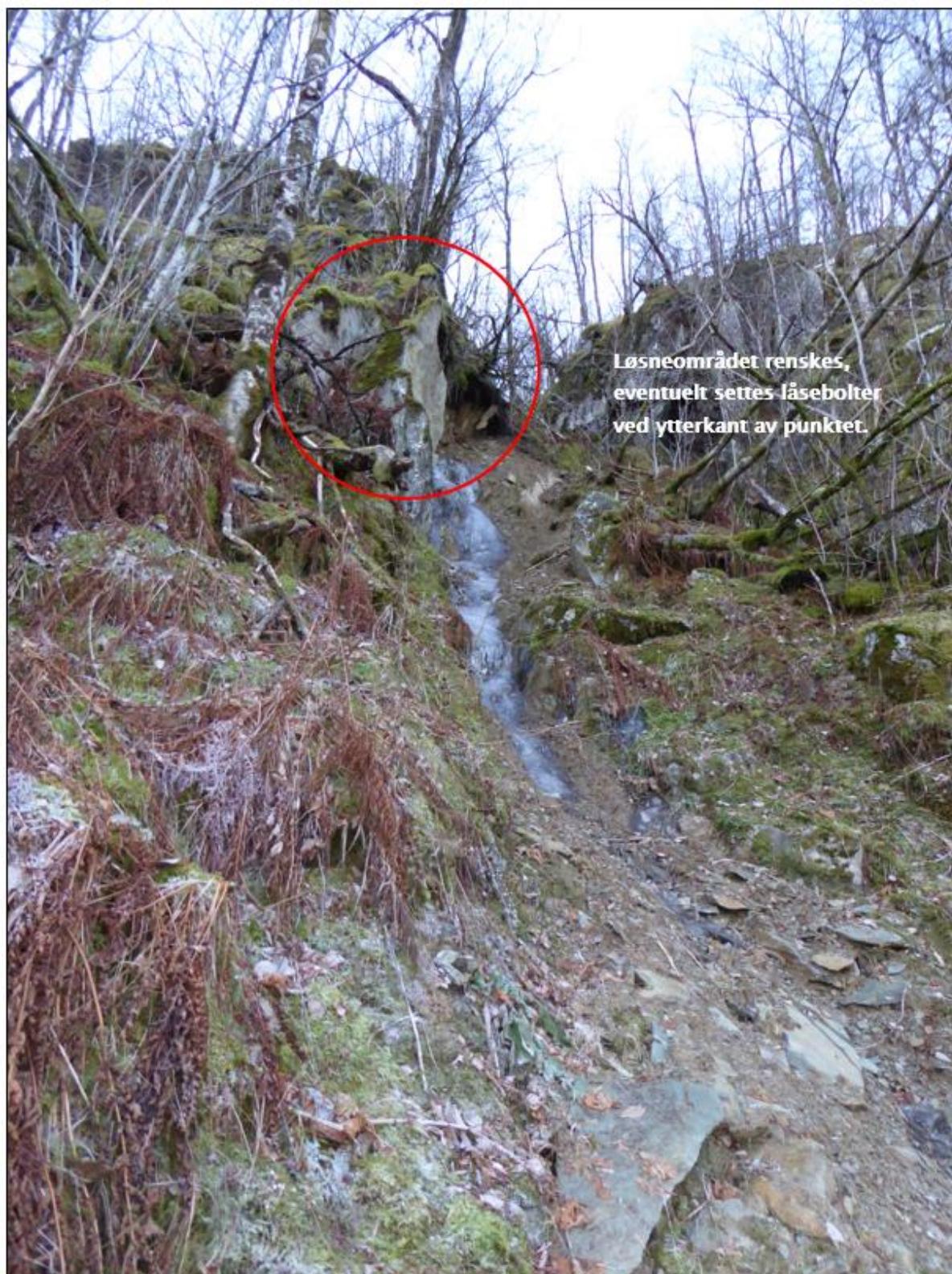
Figur 1: Løsneområdet for steinsprang. Løsneområdet renskes for løse blokker, det kan bli behov for å sette enkelte bolter for å hindre utfall av større steinblokker.
