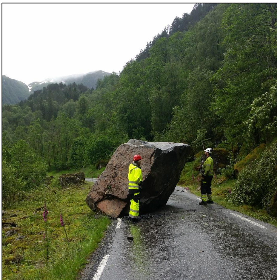
Figur 1: Steinblokk på ca. 12 m 3 traff vegbanen etter steinspranghendelse 21.07.2015.
