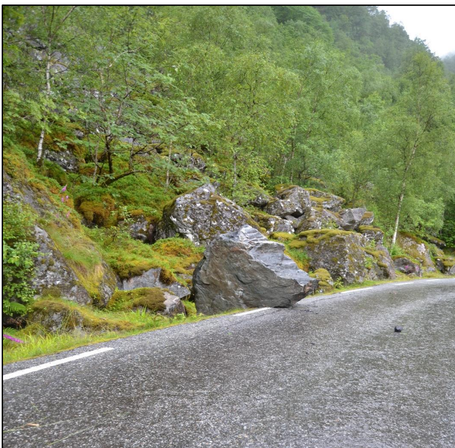
Figur 2: En mindre steinblokk traff vegbanen ca. 30 m lengre øst.
