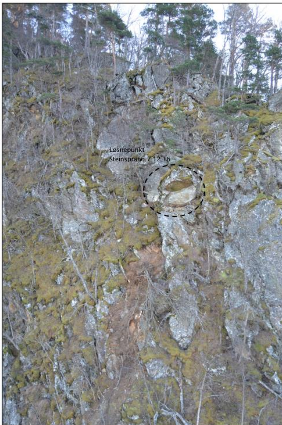
Figur 3: Løsnepunkt for steinsprang ble lokalisert i terrenget om lag 450 meter over vegbane.
