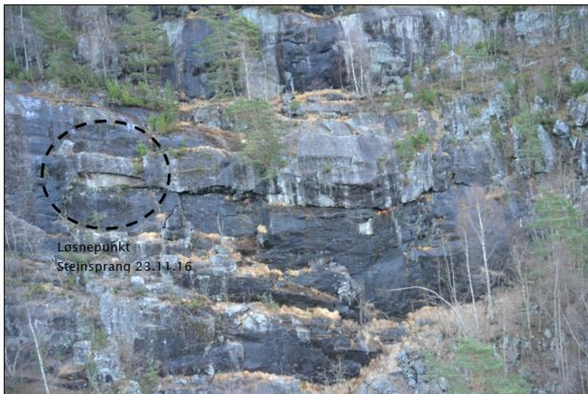
Figur 5: Løsnepunkt for steinspranget 23.11.16 ble lokalisert i bergveggen om lag 50 meter over vegbane.
