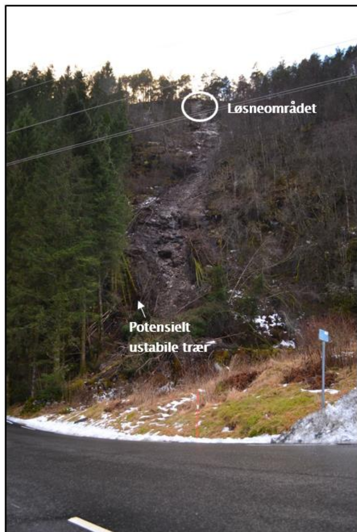
Figur 2: Bilde vedlagt bekymringsmelding. Steinblokk har trolig løsnet i terrenget og ført med seg løsmasser, stein og trær ned. Bildet viser at det er en del vann i terrenget.
