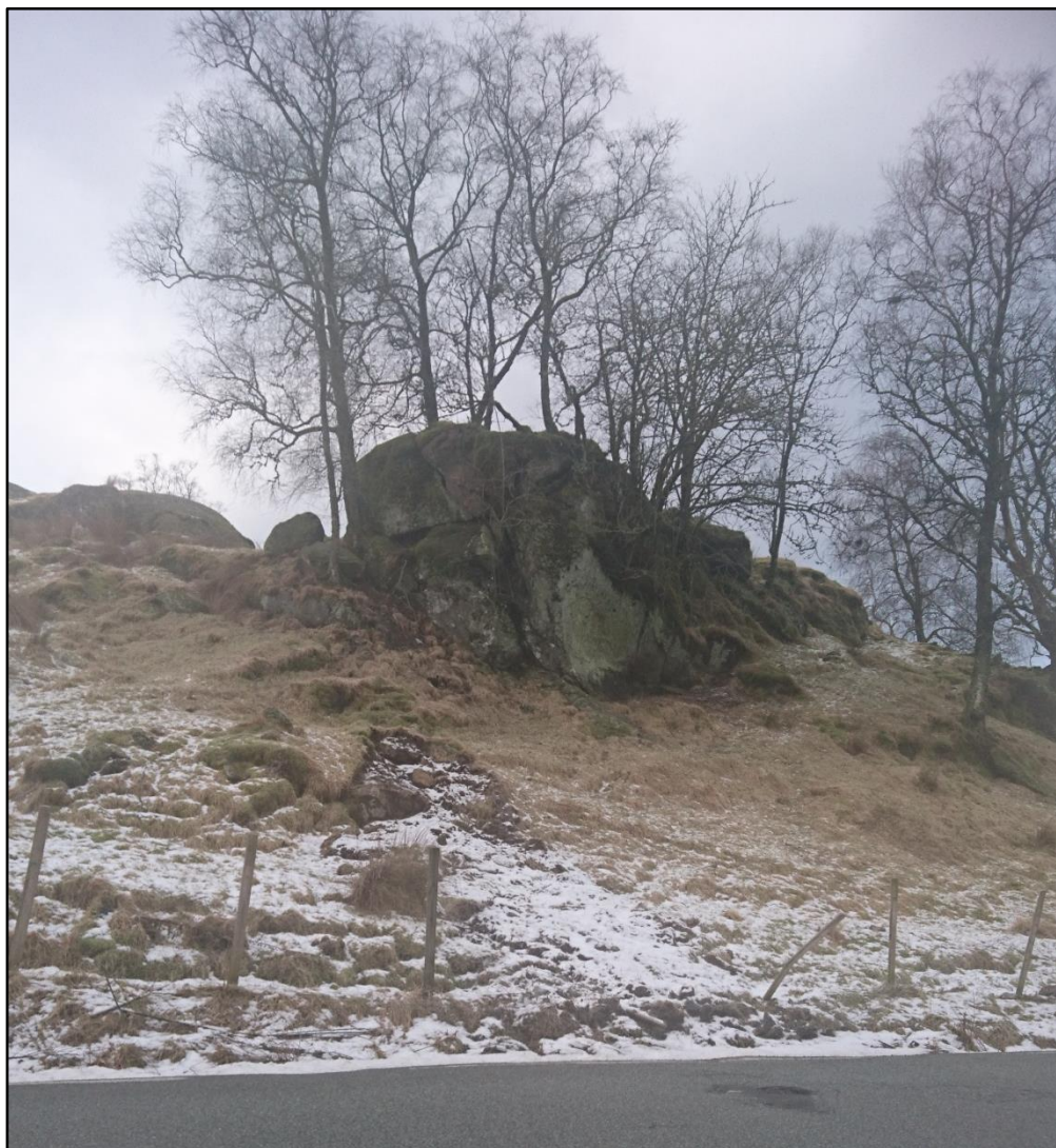
Figur 1: Bergknaus i terrenget ved hp 3 km 3,999. Eventuelle nedfall fra bergknausen vil være mindre steinblokker som løsner i ytterkant, disse vil trolig ikke treffe vegbane.
