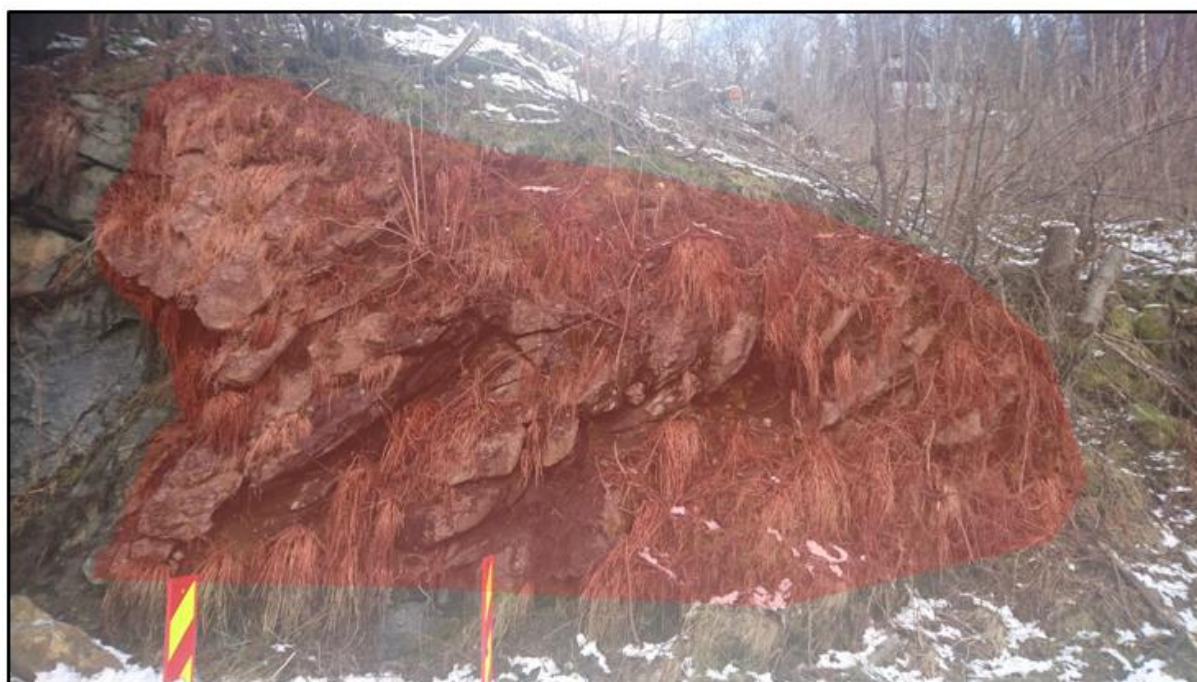
Figur 4: Markert området bør pigges ned, slik at man kommer inn til friskt berg. Piggingen bør avgrenses til sprekkeflaten parallelt skjæringen (figur 3). Eventuelle behov for supplerende sikring vurderes etter nedpigging, samt behov for sikring av løsmasser på skjæringstopp.
