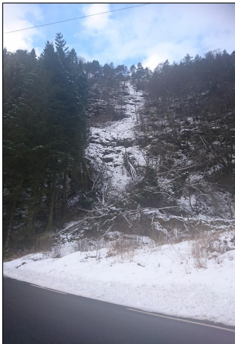
Figur 3: Bilde av skredløpet 26.02.2016. Skredmassene som ligger igjen vil fungere som en demper for utrasing av eventuelle rester i skredløpet.
