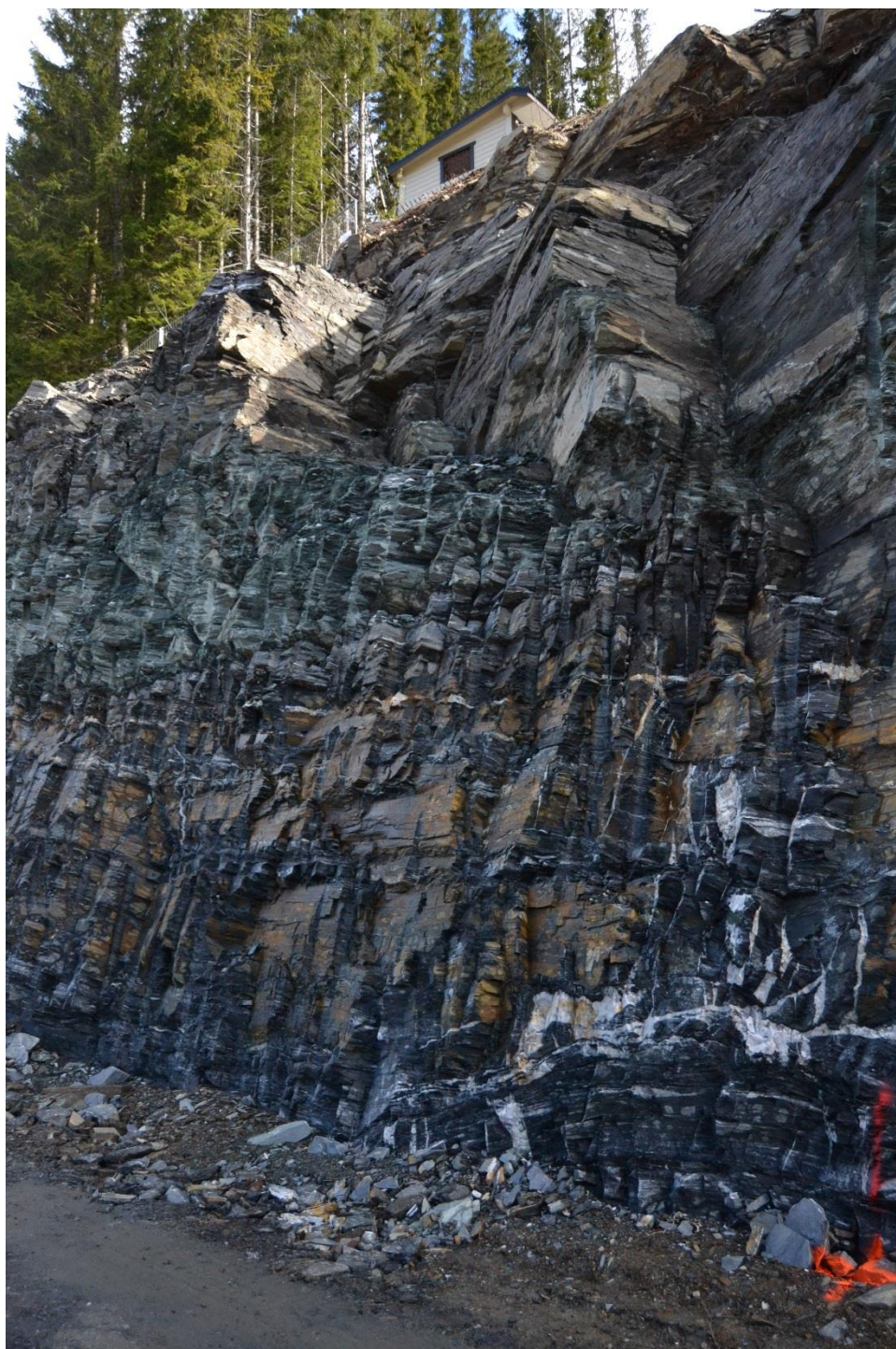
Figur 2: Skjæringen består av kvartsskifer og er godt oppsprukket.
