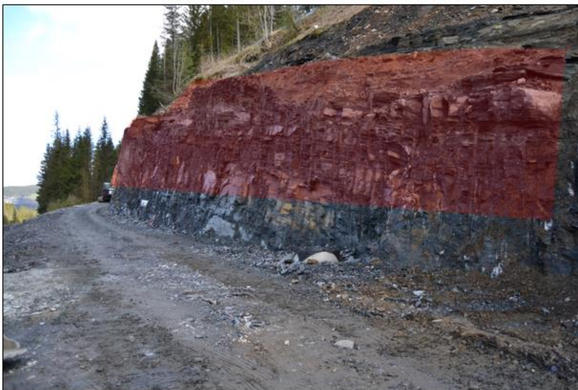
Figur 3: Skjæringen sikres med steinsprangnett fra ca. pel 285 til ca. pel 340. Nettet avsluttes 2 m over ferdig gangveg.
