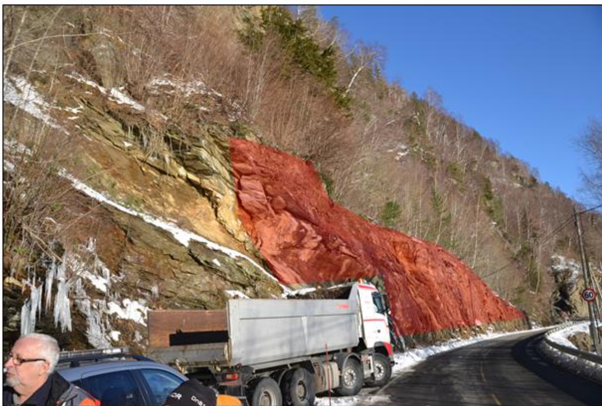
Figur 5: Skjæring ved km 3, 100 – 3,300 kan vurderes for rensk og sikring.
