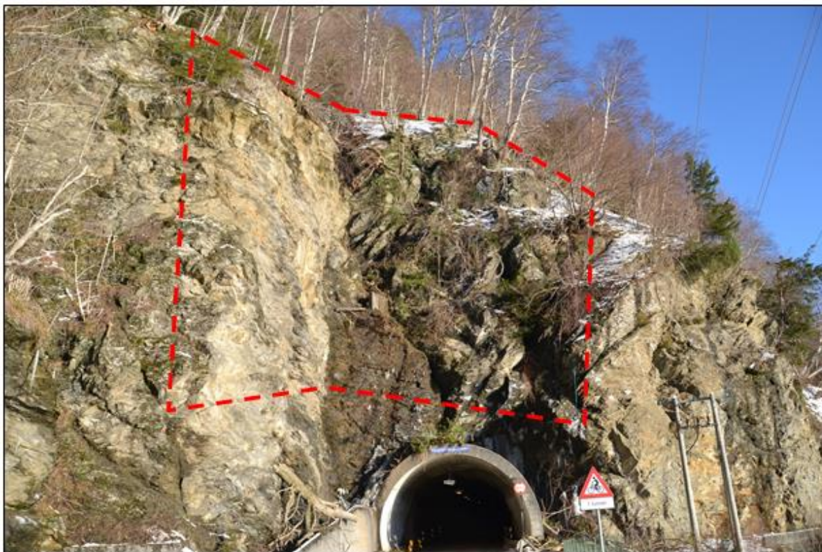
Figur 2: Oversiktsbilde av partiet over tunnelportalen. Partiet ligger ca. 35-40 m over vegbanen. Stiplet linje viser områder hvor det anbefales rensk og sikring.
