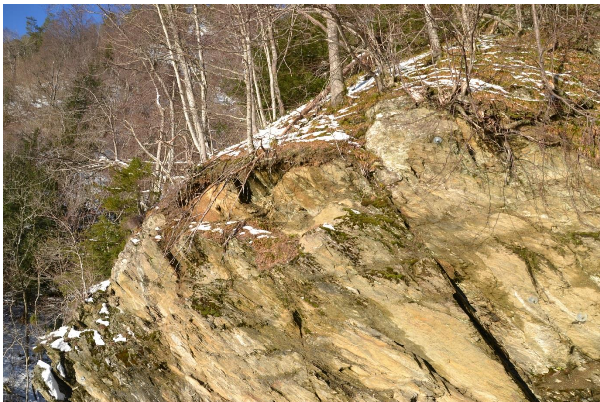
Figur 4: Skjæringstoppen renskes for vegetasjon og eventuelle løse steiner og løsmasser.
