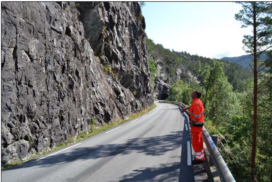
Bilde 1. Vegen sett fra ca. Hp3 km13,95 mot tunnelen.
