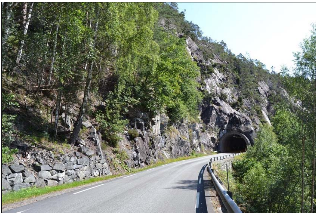
Bilde 3. Urskråning under bratt skrent og flere steinsprangblokker som ligger bak trær.
