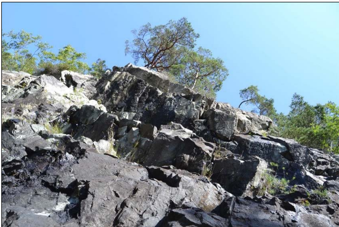
Bilde 9. Overhengende partier direkte over vegen med løse blokker på kanten av hyllene.
