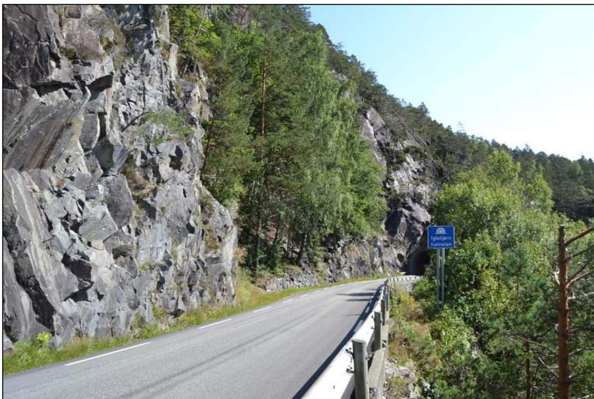
Bilde 2. Litt nærmere tunnelen.
