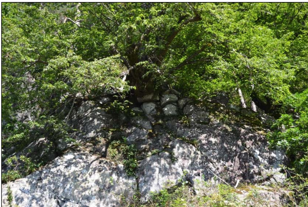
Bilde 7. Løse trær i røttene på et tre som henger 15 m over vegen.
