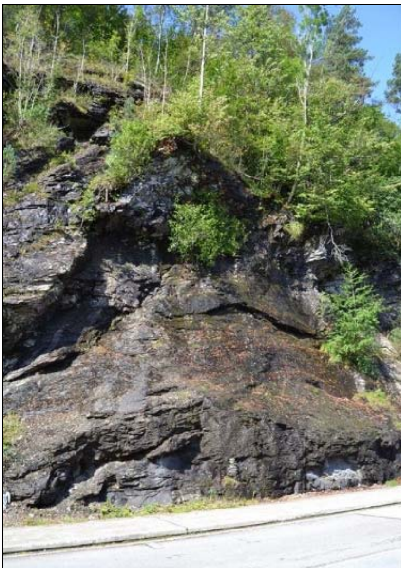
Bilde 9. Bergskjæringen over parkeringslomma.
