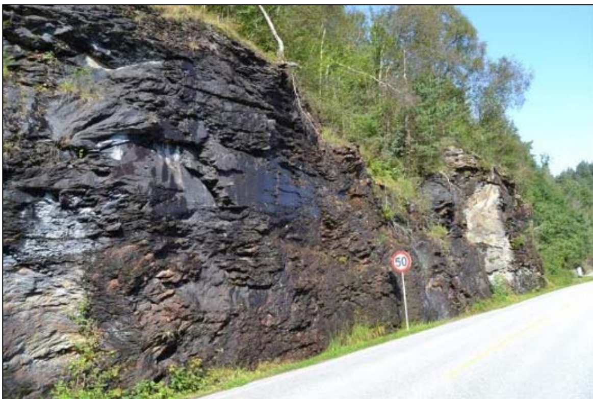
Bilde 5. Dagens bergsjæring ved ca. km20,750.
