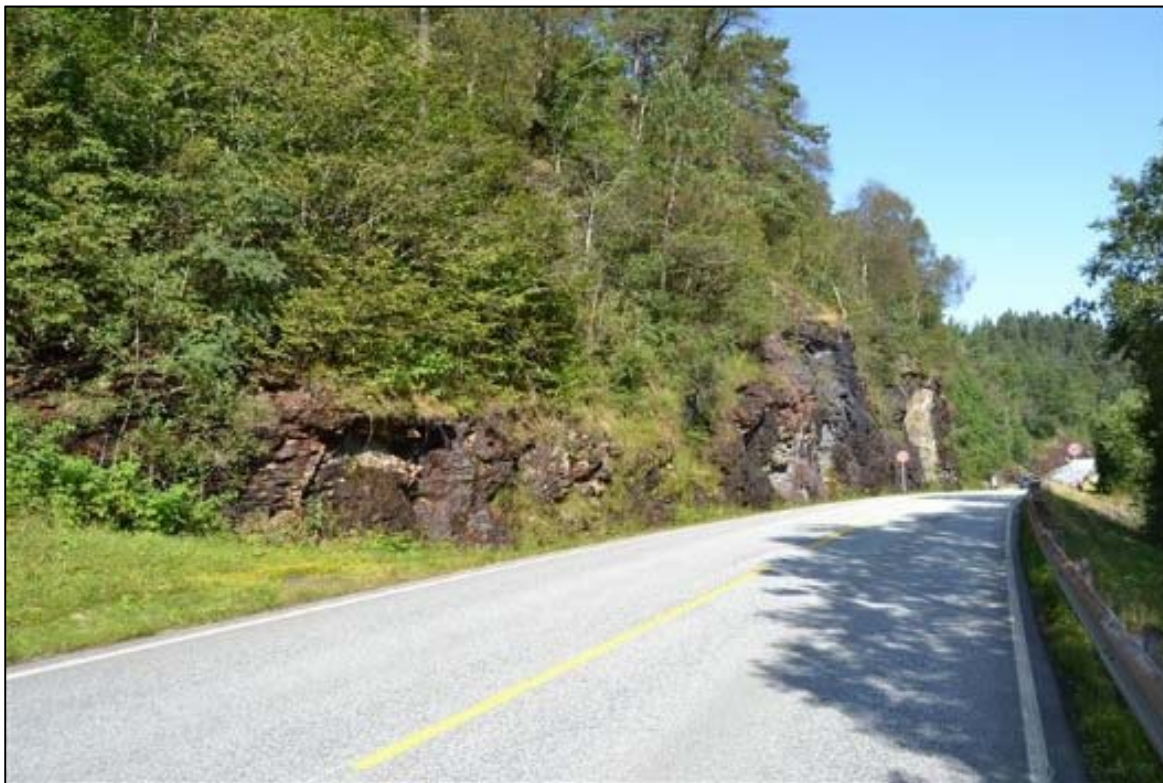
Bilde 1. Vegen sett fra ca. Hp1 km20,690 mot nord.
