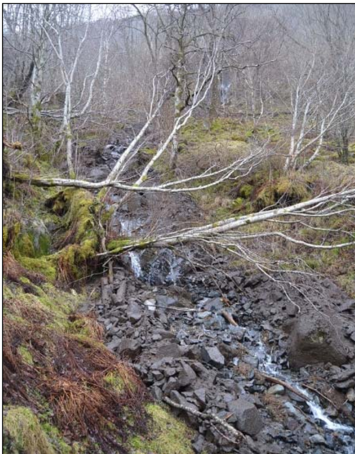
Bilde 4. Det ligger igjen betydelige mengder med stein i bekkeløpet oppover fjellsiden.
