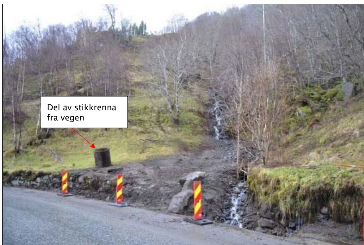
Bilde 1. Bekkeløpet sett fra vegen. Entreprenør har allerede fjernet jord- og steinmasser som lå i grøftekant og over vegen.
