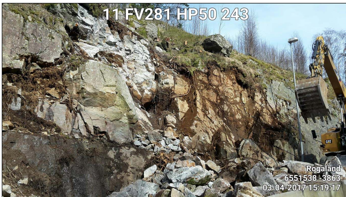
Bilde 3. Første del av skjæringen etter forsiktig rensk. Store partier har rast ned.
