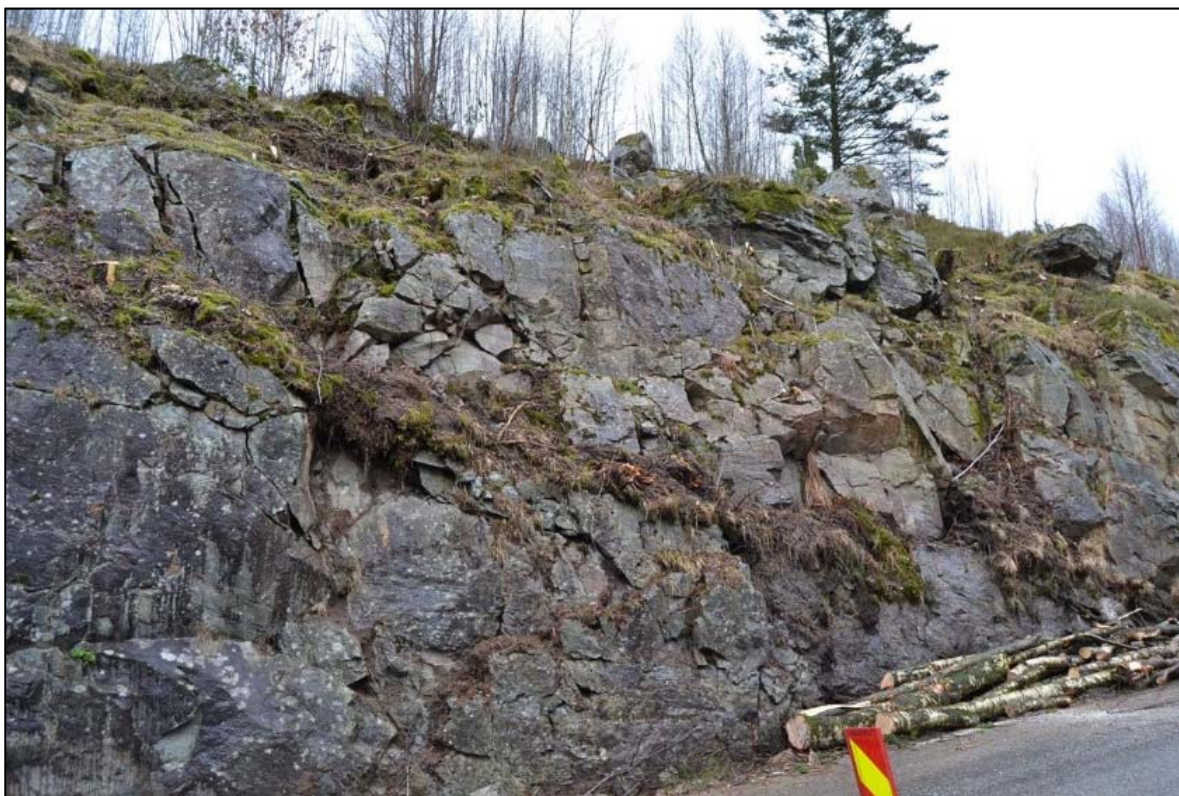
Bilde 2. Første del av bergskjæringen etter vegetasjonrensk men før bergrensk.
