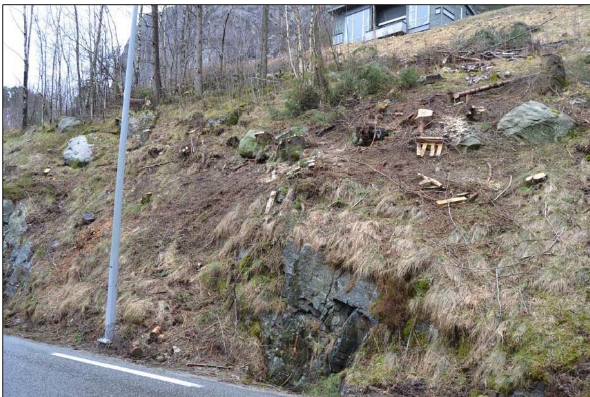
Bilde 5. Siste del av skråningen som for det meste består av løsmasser.
