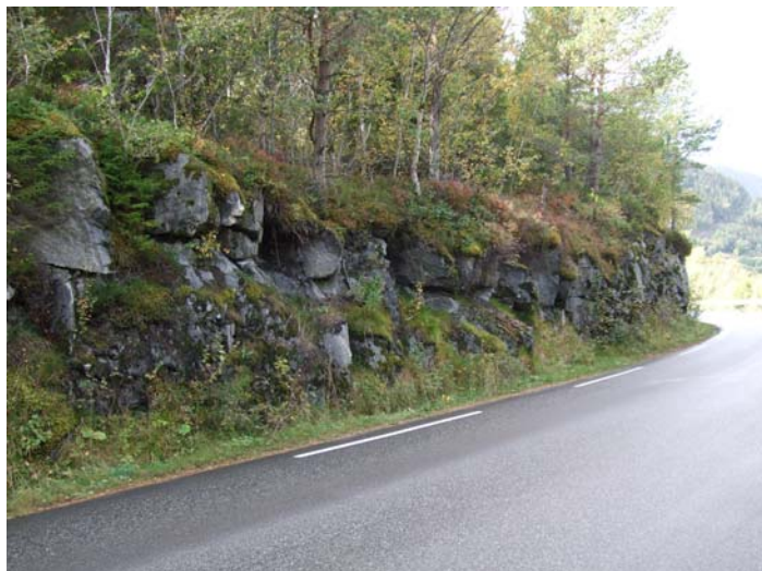
Bilde 2: Skjæring B sett mot øst.
