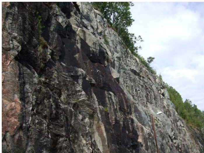
Bilde 9: Skjæring K sett mot øst.
