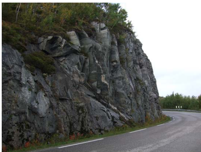
Bilde 10: Skjæring L sett mot øst, der sleppe vises i framkant.
