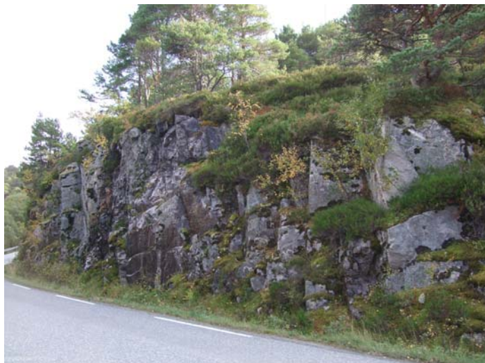
Bilde 7: Skjæring G sett mot vest.
