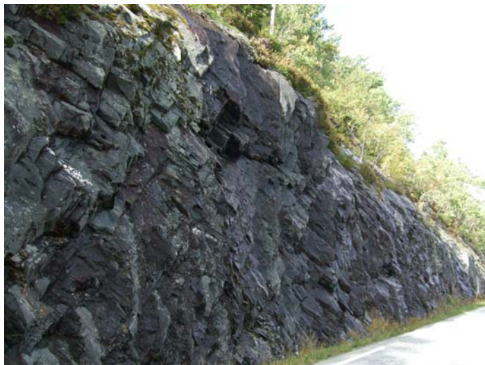
Bilde 6: Skjæring F sett mot øst.
