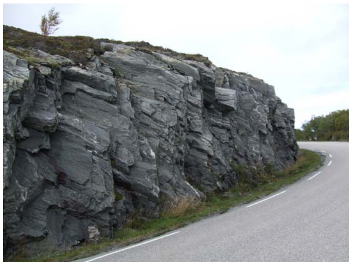
Bilde 11: Skjæring M sett mot øst.
