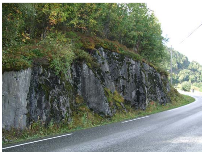
Bilde 3: Skjæring C sett mot øst.
