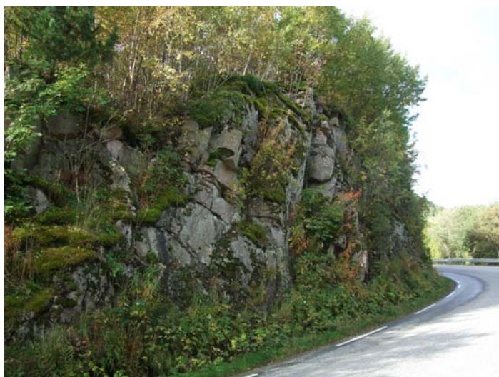
Bilde 1: Skjæring A sett mot øst.
