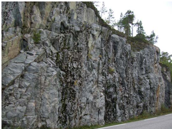
Bilde 8: Skjæring J sett mot øst.
