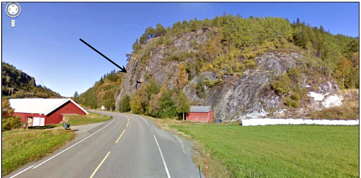
Figur 4: Foto av bergskjæringen i Arnvika sett mot nordøst. Løsneområde er omtrent der pil peker. Kilde: GoogleMaps (ref 1),
