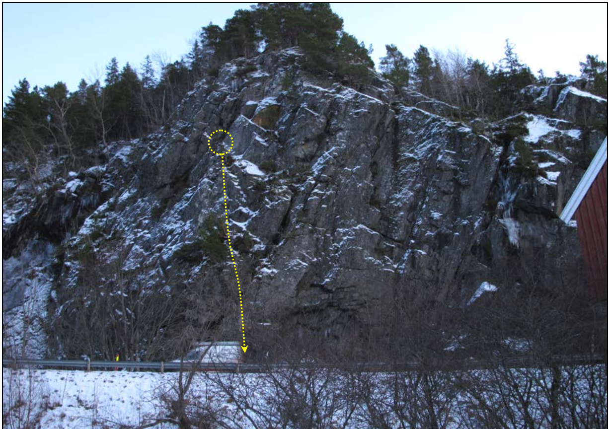
Figur 3: Foto av bergskjæringen sett mot øst. Løsneområde i gul sirkel, ca. 12 meter over veggen. Stipla gul stripe med pil indikerer antatt rasbane for steinblokker. Merk 2 meter høy bil som skala
