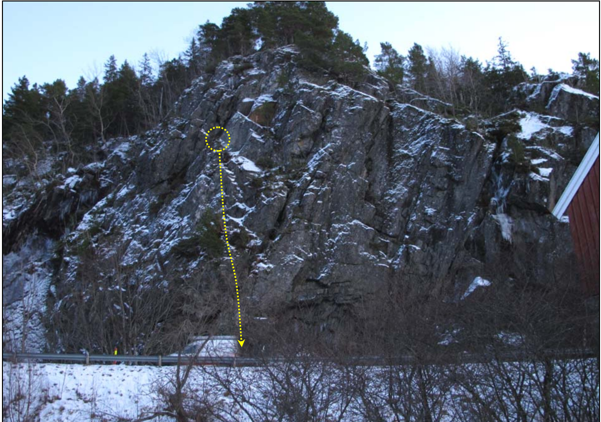
Figur 3: Foto av bergskjæringen sett mot øst. Løseområde i gul sirkel, ca. 12 meter over veien. Stipla gul stripe med pil indikerer antatt rasbane for steinblokker. Merk 2 meter høy bil som skala
