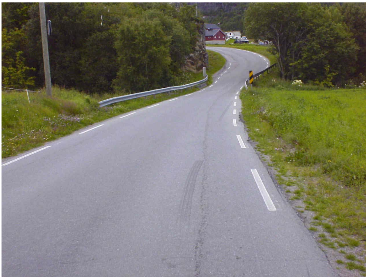
Bilde 1: Oversiktsbilde, sett mot vest. Bergskjæring som skal utvides ses på venstre side etter elva.
