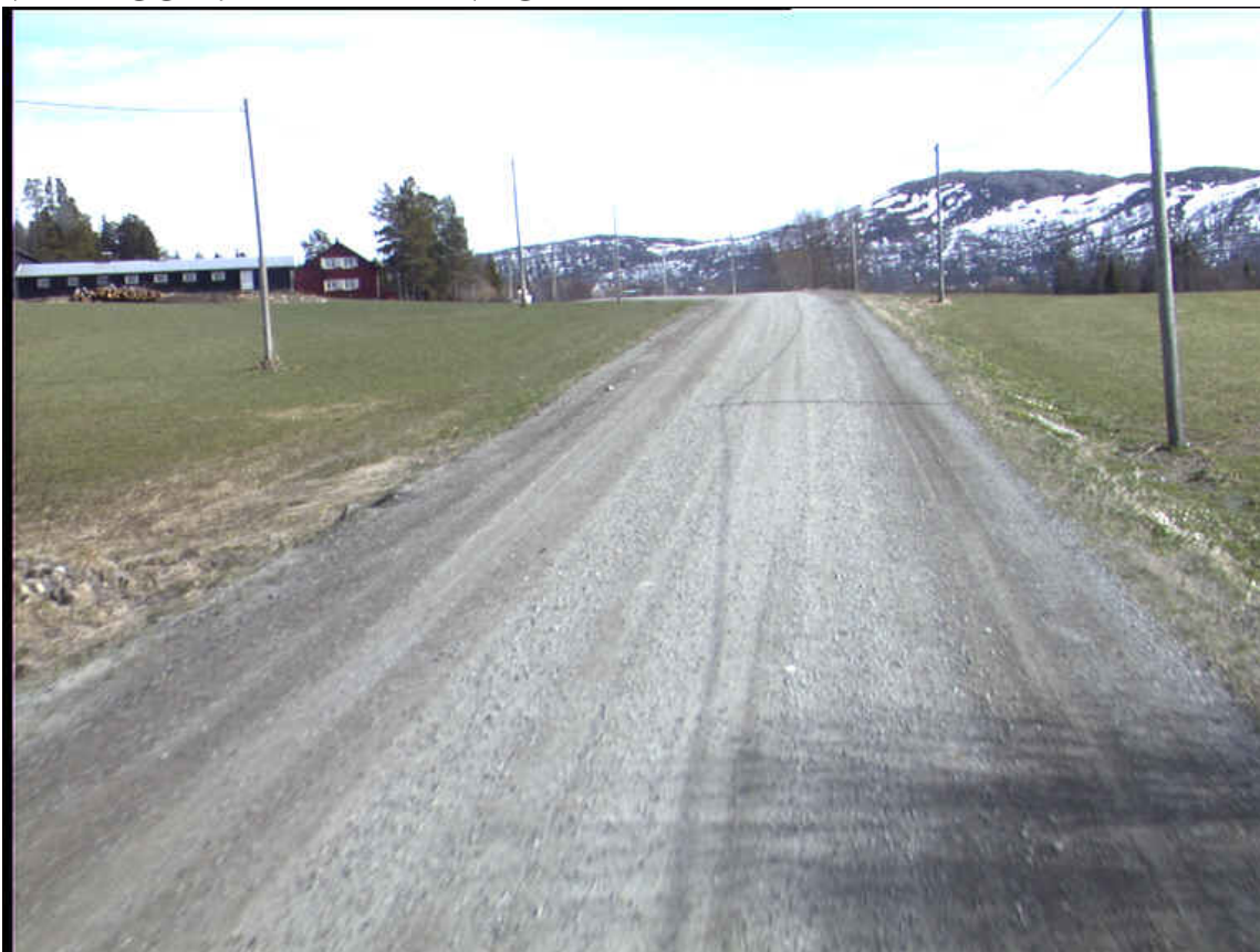
Start strekning med Dustex, km 14,635
