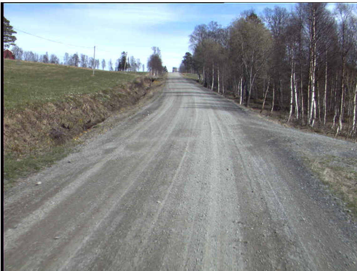
Start strekning med redusert bitumen%, km 15,300
